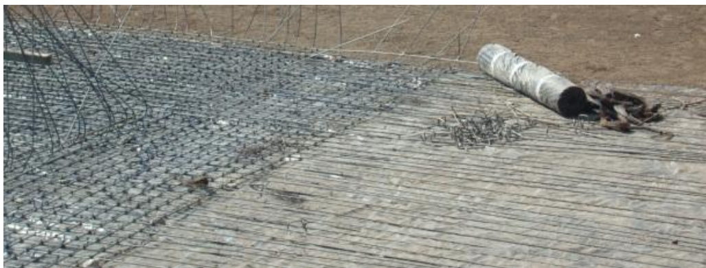
Figura 4.48. Membrana impermeable y acero.
