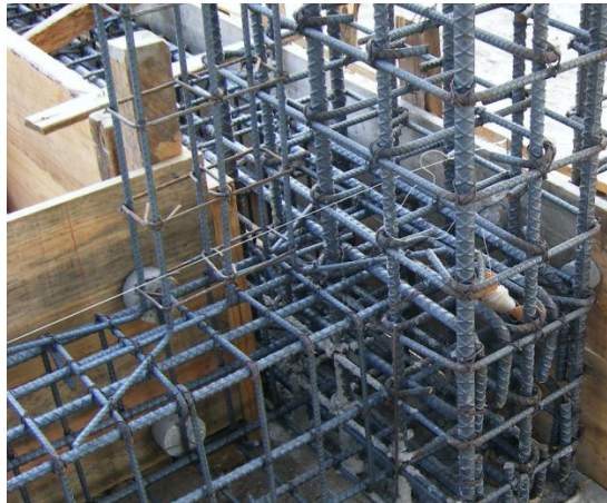
Figura 4.38. Intercepción del acero y cimbrado en muros.
