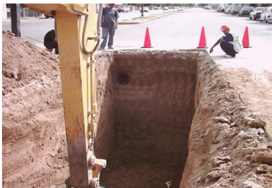
Figura 4.2. Excavación en etapas.
