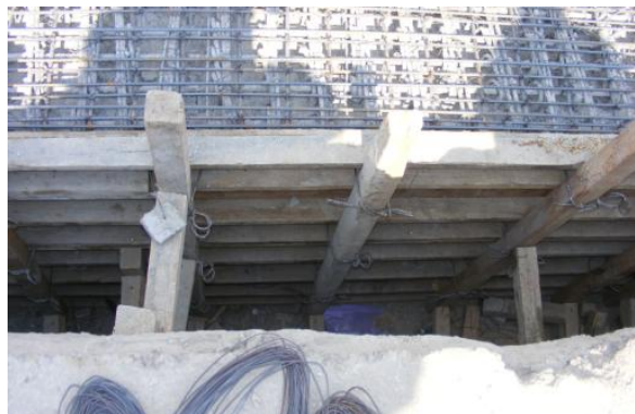
Figura 4.39. Colocación de puntales.
