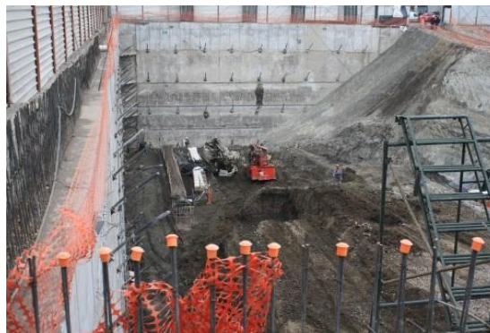
Figura 4.14. Uso de anclas en excavaciones profundas.
