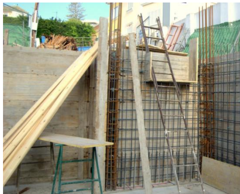
Figura 4.8. Colocación de madera como estructura provisional.
