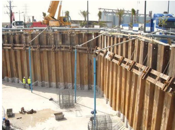
Figura 3.30. Tablestacas arriostradas con anclajes.
