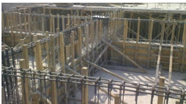
Figura 4.36. Muro de cimentación.
