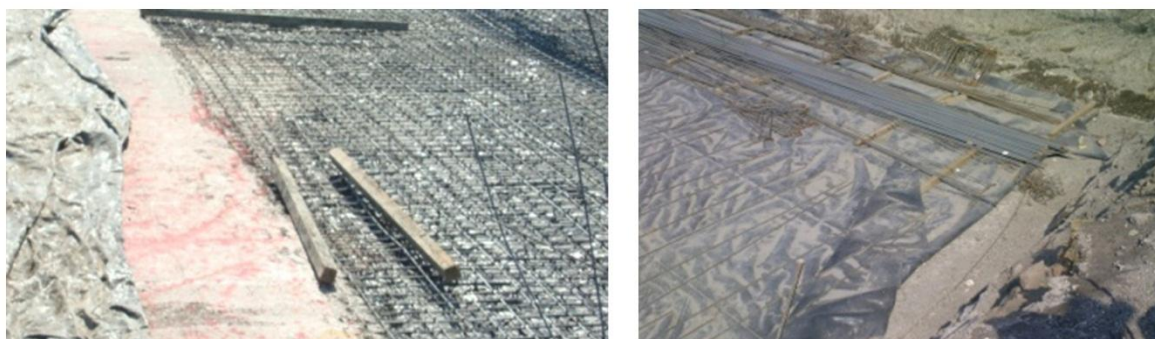
Figura 4.49. Membrana impermeable y habilitación del acero.
