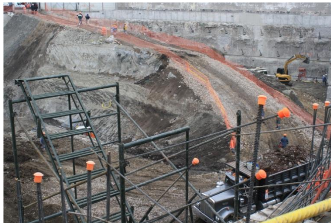
Figura 4.4. Seguridad en el acceso.
