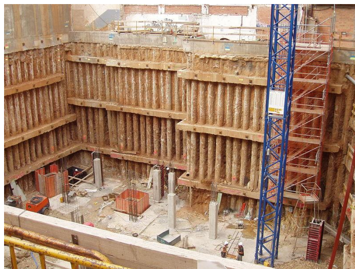
Figura 3.32. Pilas secantes.
