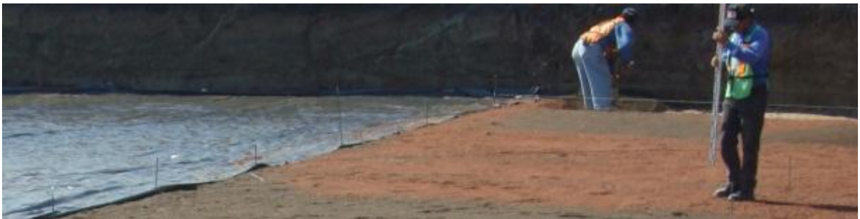
Figura 4.47. Colocación de la membrana impermeable.
