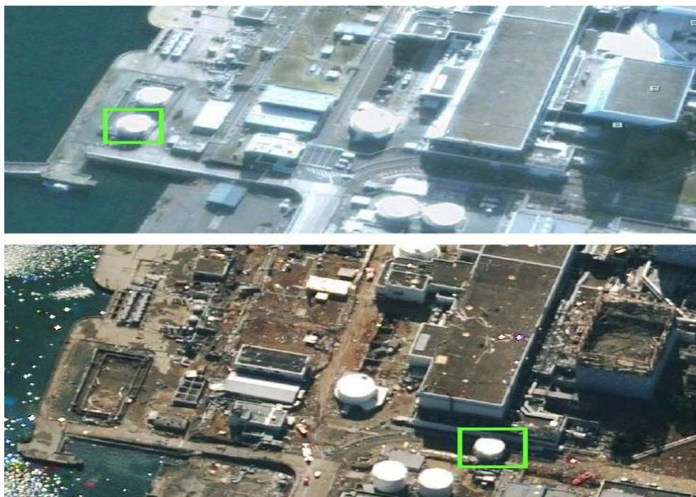
Figura 4. Impacto del Tsunami en la CNFD
