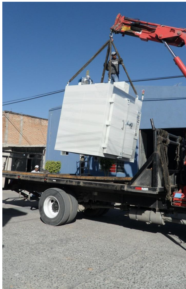
Se utiliza el servicio de grúa para el transporte del horno a la planta.
