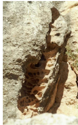
Fig. 2 Grieta kárstica en roca caliza
