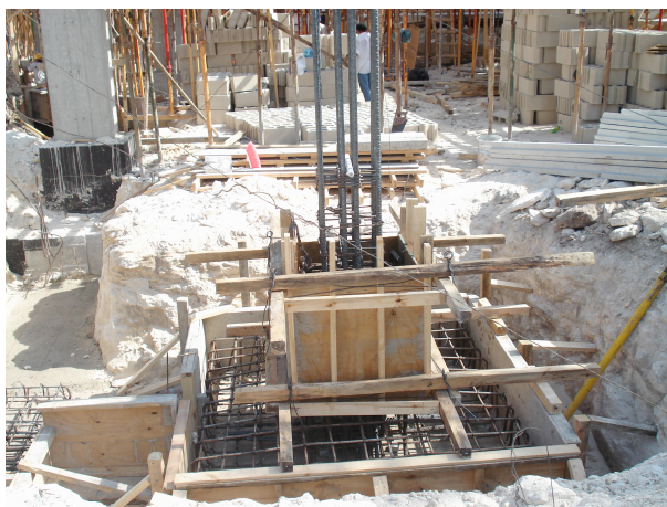
Zapata Aislada sobre roca Sana (sobre estrato de Sascab) en Playa del Carmen
