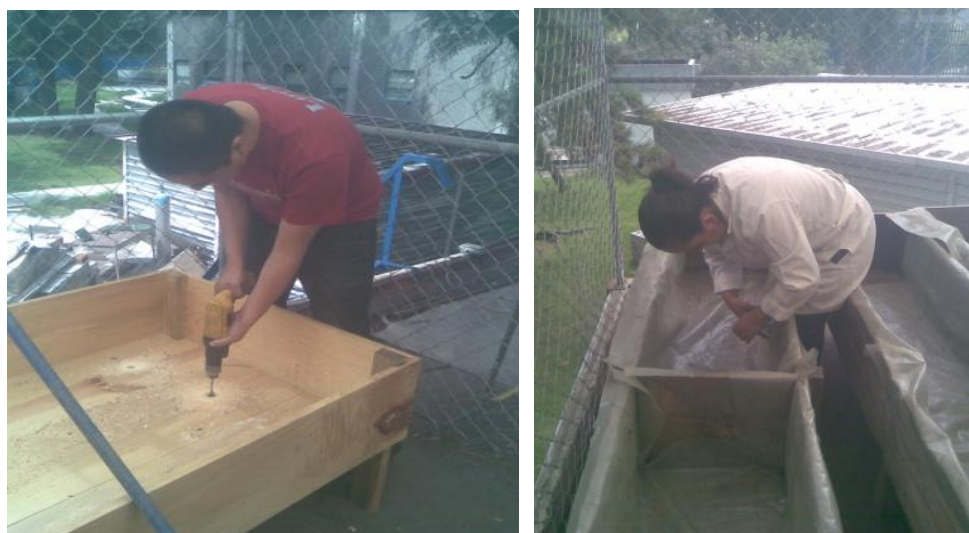
Figura 5.4 Perforación y forrado de cajones
