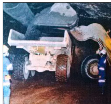
Figura 3.4 Retiro de rezaga en el interior de un túnel con la ayuda de un cargador frontal y camión articulado.
