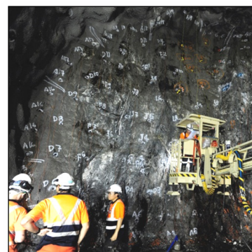
Figura 3.2 Colocación de explosivos en los barrenos perforados.
