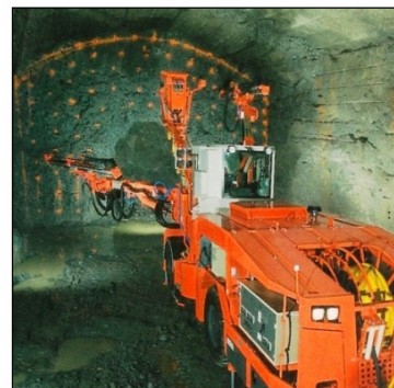
Figura 3.1 Perforación en sección de túnel con ayuda de una plantilla. [60] López Jimeno (2011).
