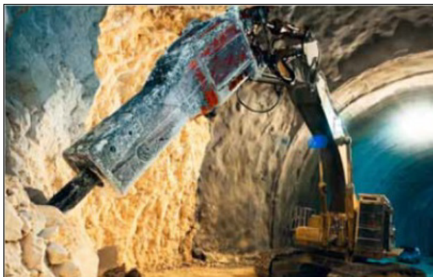
Figura 3.65 Excavadora portando un martillo hidráulico. [101] Sandvik.
