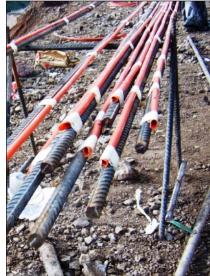
Figura 4.6 Anclas de acero con la manguera de plástico sujeta en ellas. Utilizadas en la construcción de la C. H. La Yesca.
