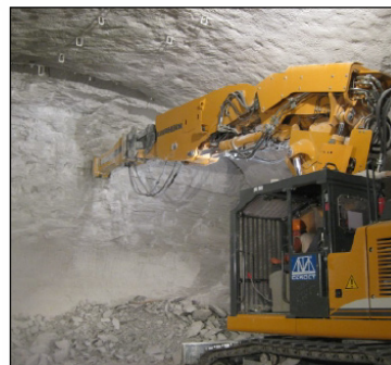
Figura 3.3 Amacice del terreno, después de realizada la voladura.
