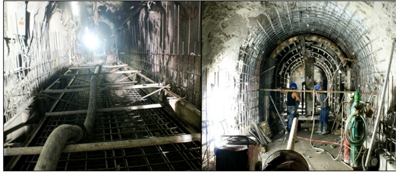
Figura 5.10 Revestimiento de sección portal, en una de las galerías para tratamiento del macizo rocoso, en la construcción de la C. H. La Yesca. Izquierda: Plantilla y arranque de muros listos para la colocación de concreto, primera etapa; Derecha: cimbra metálica posicionada para revestimiento de muros y bóveda, segunda etapa.
