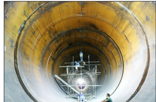
Figura 6.7 Interior de la tubería a presión, rama horizontal, en la construcción de la C. H. La Yesca.
