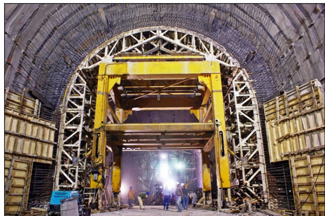
Figura 5.15 Preparativos para la colocación del revestimiento con cimbra metálica telescópica, en una zona del túnel de desvío No. 1, en la construcción de la C. H. La Yesca.
