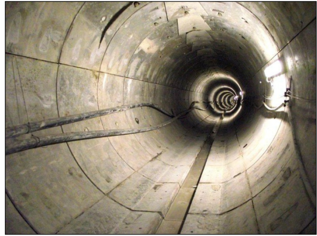
Figura 5.20 Revestimiento en túnel con anillos de dovelas. Se observa que cada anillo está formado por dos dovelas corrientes, dos de contrallave, en la plantilla una dovela de piso y la llave. [92] Geocontrol .
