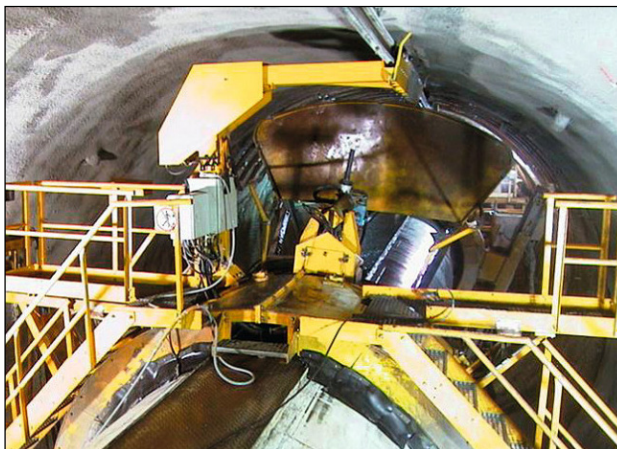
Figura 3.49 Robot para colocación de concreto lanzado como parte del equipo de apoyo. [105] Tunnel .
