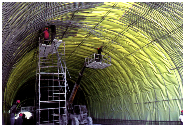
Figura 5.1 Colocación de acero de refuerzo para revestimiento con concreto armado colado en sitio. Se aprecia en la foto una membrana impermeabilizante colocada previamente. Túnel de la carretera Durango-Mazatlán, México. [97] Obrasweb.
