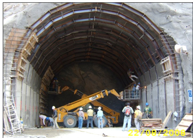
Figura 6.12 Inicio de la excavación de los túneles de acceso a la Casa de Máquinas. Se aprecian los marcos de acero retacados con concreto, para el soporte de la excavación en la entrada del túnel.
