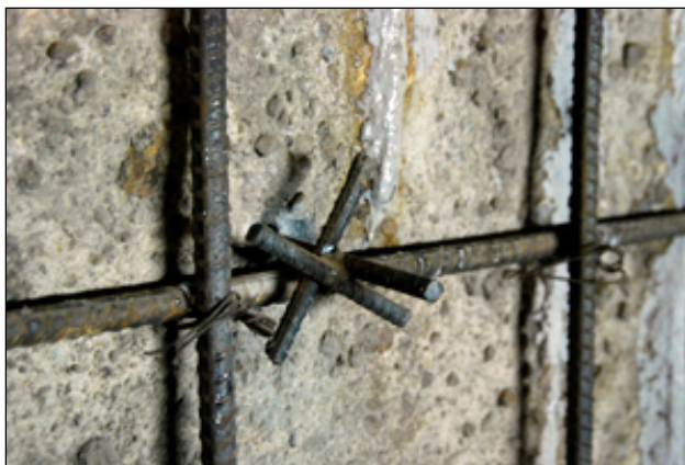
Figura 5.4 Barras de acero de refuerzo y un escantillón de acero como guía para colocar el recubrimiento adecuado de concreto lanzado. [95] Lumbreras y Túneles.
