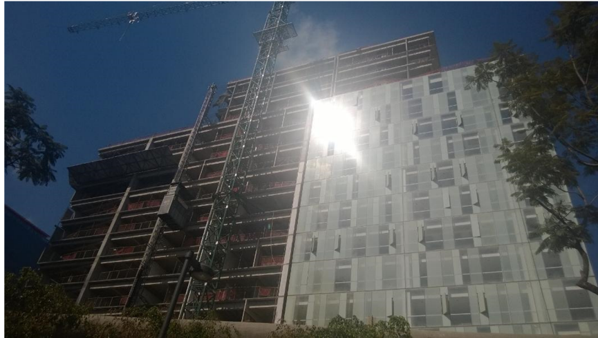
Figura 2.3 -Estado actual del edificio
