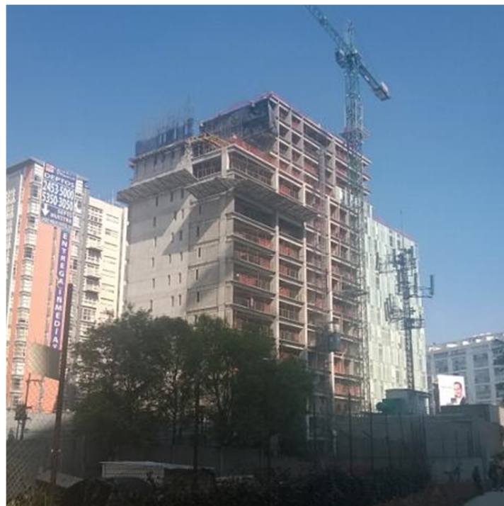
Figura 2.4 - Estado actual del edificio y edificios alrededor
