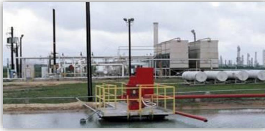
Fig. 1.12.- Planta de demostración en Texas (Geothermal energy association, 2013).
