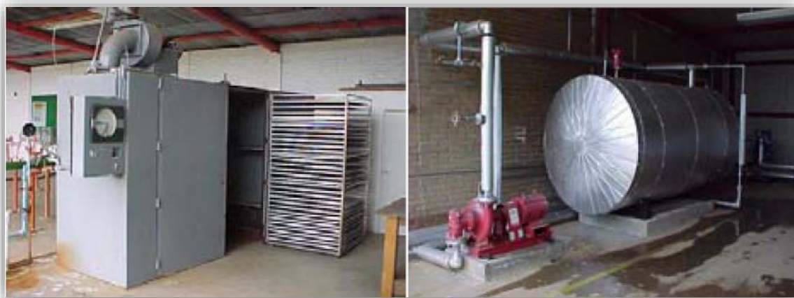
Fig. 1.21.- Deshidratador de frutas y tanque de agua caliente en Los Azufres (Alejandro, 2009).
