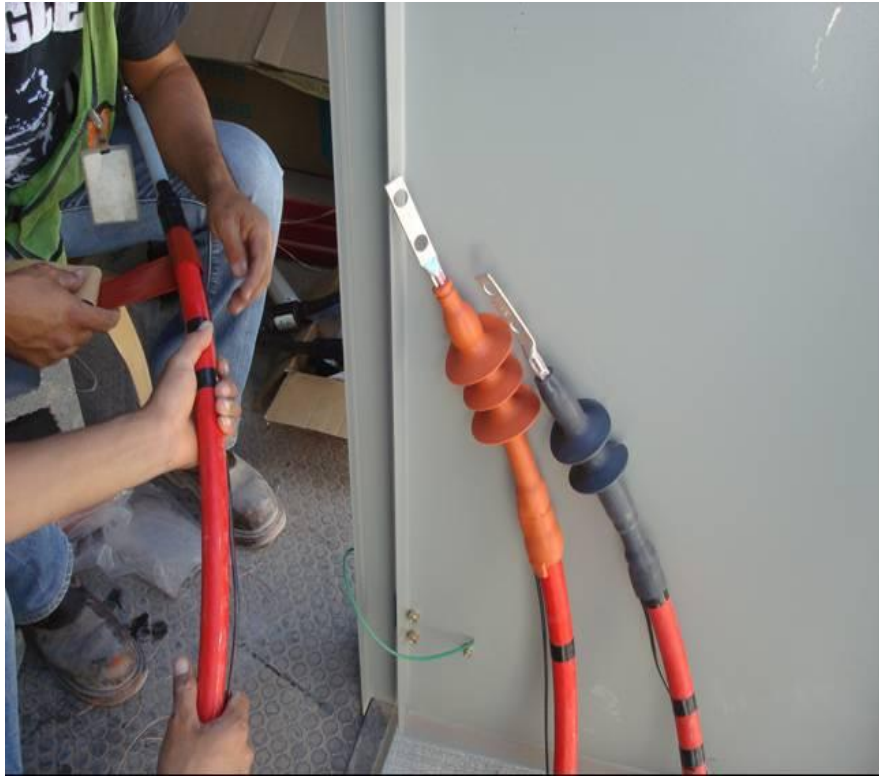
Figura 4.132. Muestra otro proceso de la colocación del cableado en media tensión tipo XLP, para las tres fases necesarias (Baselis, 2010)
