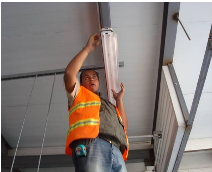
Figura 4.97. Colocación de luminarios fluorescentes a prueba de vapor en subestación de azotea (Baselis, 2010)
