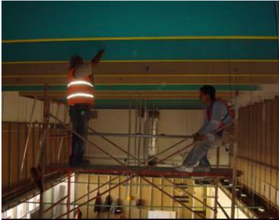
Figura 4.69. Maniobras para instalación de soportería y charola en las alturas con el uso de andamios (Baselis, 2010)
