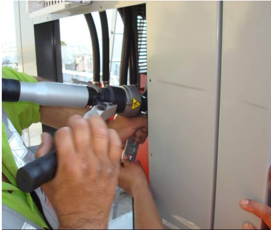
Figura 4.124. Muestra el proceso de colocación de zapatas ponchables para la conexión de equipos en la subestación (Baselis, 2010)
