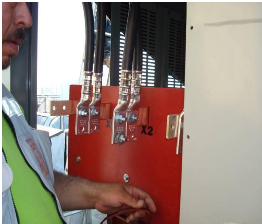
Figura 4.125. Muestra el proceso de colocación de zapatas ponchables para la conexión del transformador en la subestación, dos hilos por fase del calibre 600 kCM (Baselis, 2010)
