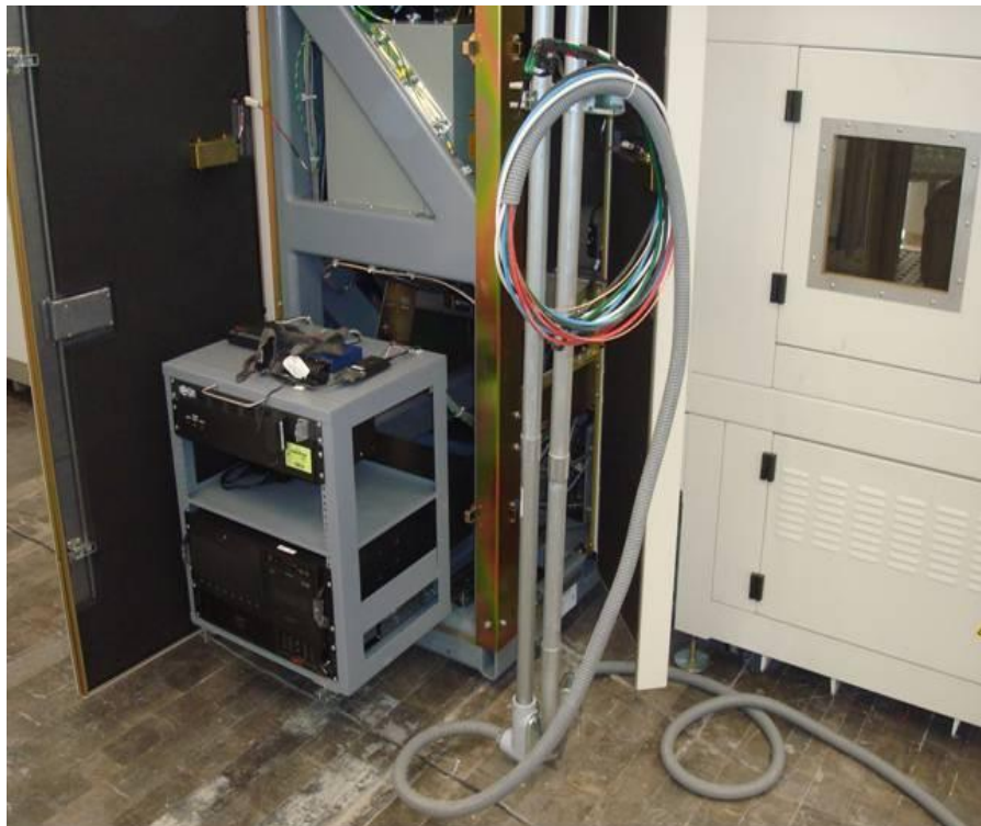
Figura 4.149. Muestra la llegada de la alimentación eléctrica al equipo tipo “eXaminer” (se ve su estructura interna de alimentación) (Baselis, 2010)
