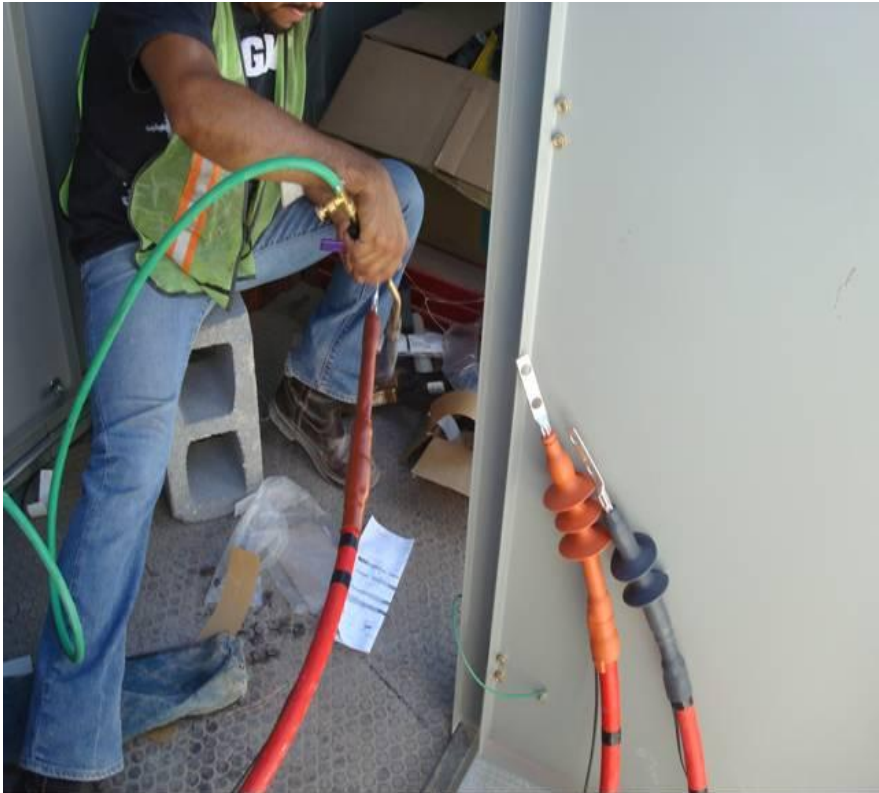
Figura 4.133. Otro proceso de la colocación del cableado en media tensión tipo XLP, para las tres fases necesarias (Baselis, 2010)
