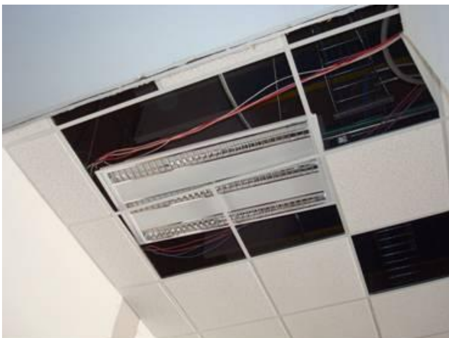
Figura 4.85. Forma general del reticulado para el falso plafón en el área de bandas transportadoras (Baselis, 2010)
