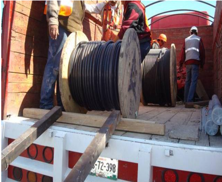
Figura 4.120. Muestra el proceso de descarga desde el transporte del cable para los alimentadores principales (Baselis, 2010)
