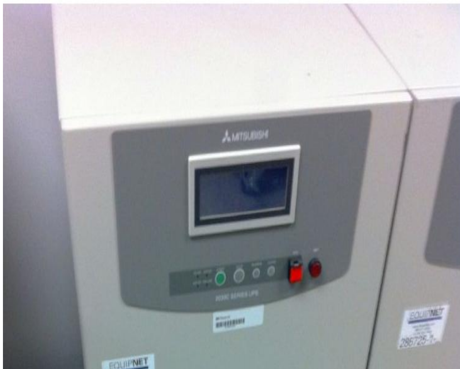
Figura 4.147. Muestra el equipo UPS Mitsubishi de 20 kVA para respaldo de los equipos “eXaminer” (Baselis, 2010)
