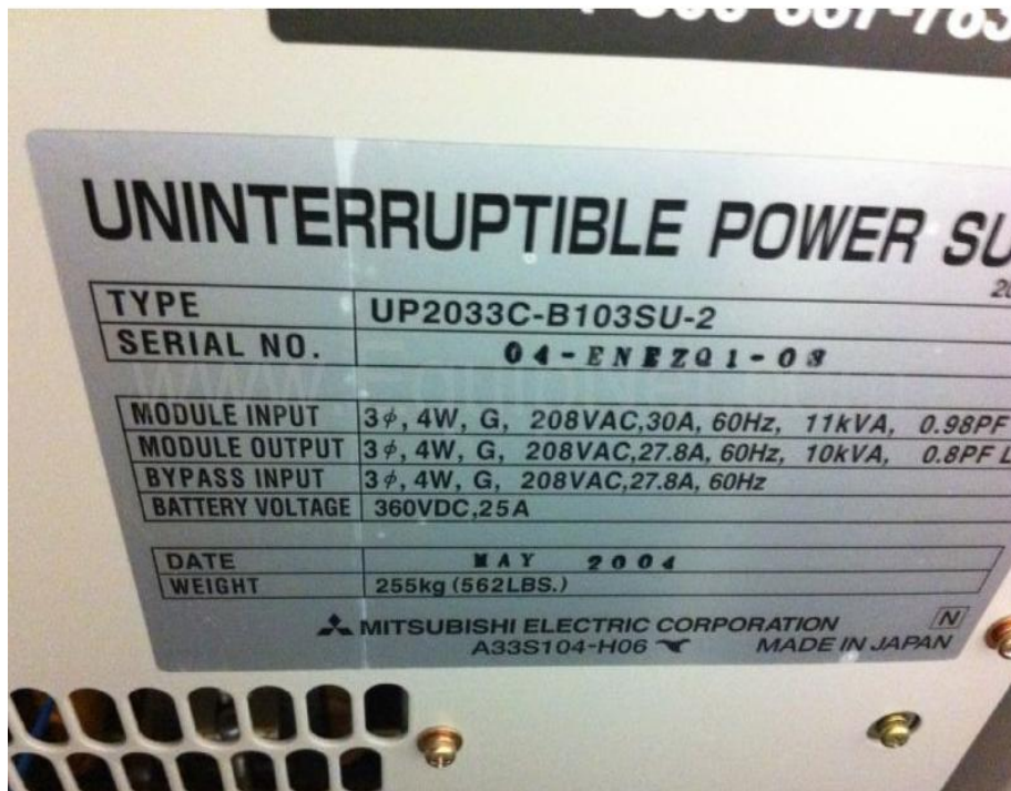
Figura 4.146. Muestra la placa de datos del equipo UPS para respaldo de los equipos “eXaminer” (Baselis, 2010)
