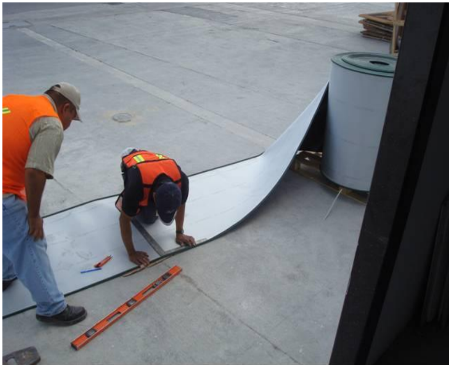
Figura 4.159. Esquema de corte y unión de la banda de hule para cada módulo del sistema de las bandas transportadoras antes de su acomodo final (Baselis, 2010)
