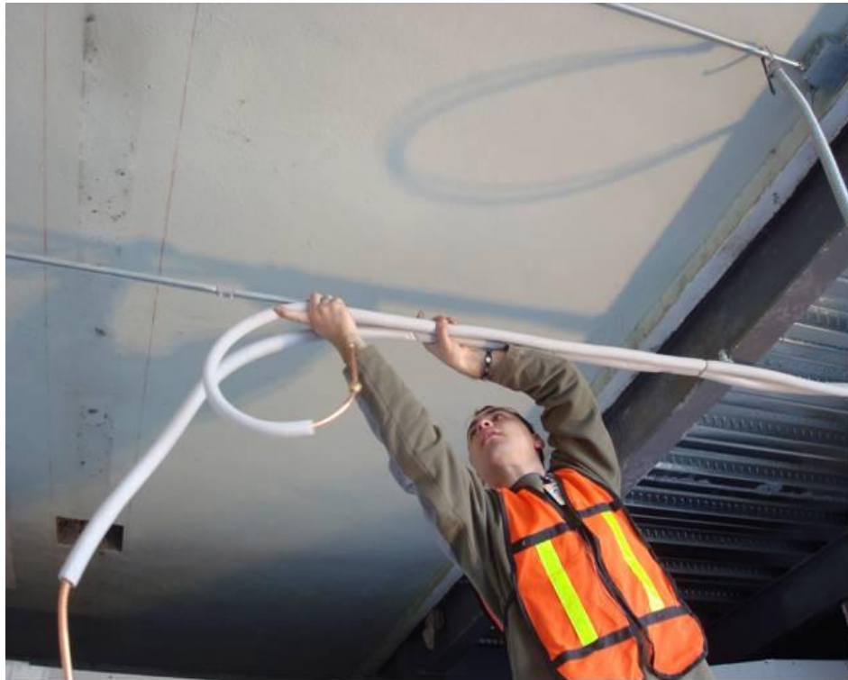
Figura 4.106. Colocación de tuberías de cobre para refrigeración e incluye también alimentación eléctrica (Baselis, 2010)
