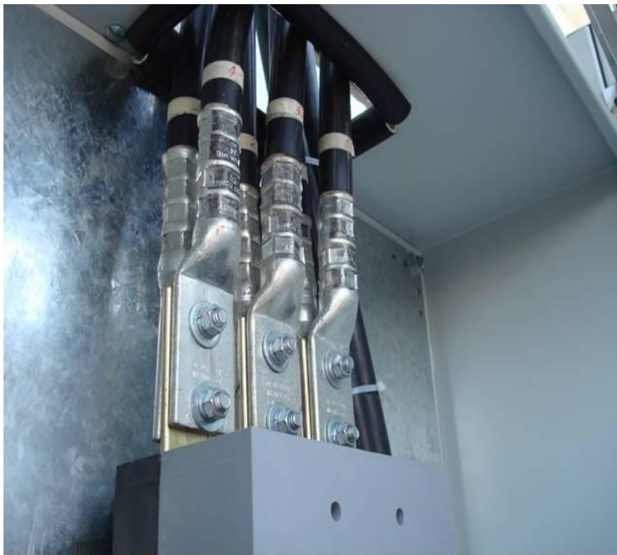
Figura 4.129. Muestra la colocación del cableado en todos sus hilos para alimentación de interruptores en la transferencia (Baselis, 2010)
