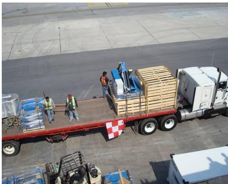
Figura 4.153. Muestra la descarga de los módulos de las bandas transportadoras del transporte mediante montacargas (Baselis, 2010)
