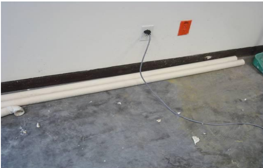
Figura 4.103. Colocación final de accesorios varios en muros (Baselis, 2010)
