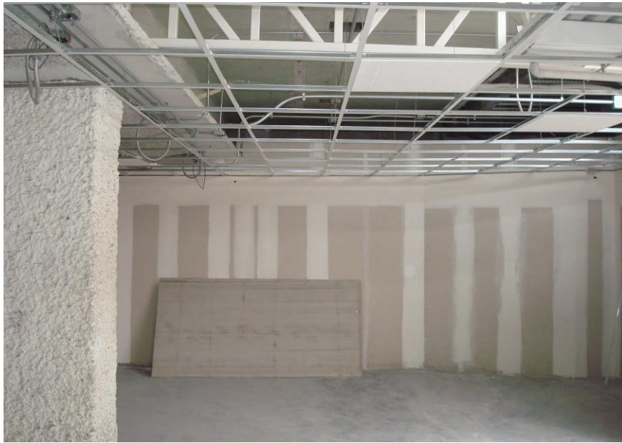
Figura 4.88. Forma general de los muros de tablaroca, antes del acabado final de pintura (Baselis, 2010)
