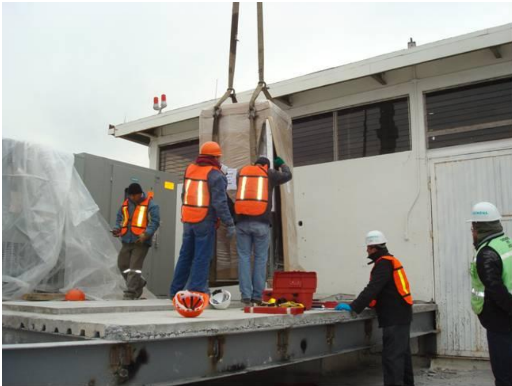
Figura 4.50. Una vez colada la base se dispone a primero colocar los equipos grandes en la subestación (transformador, planta de emergencia, etc.) (Baselis, 2010)
