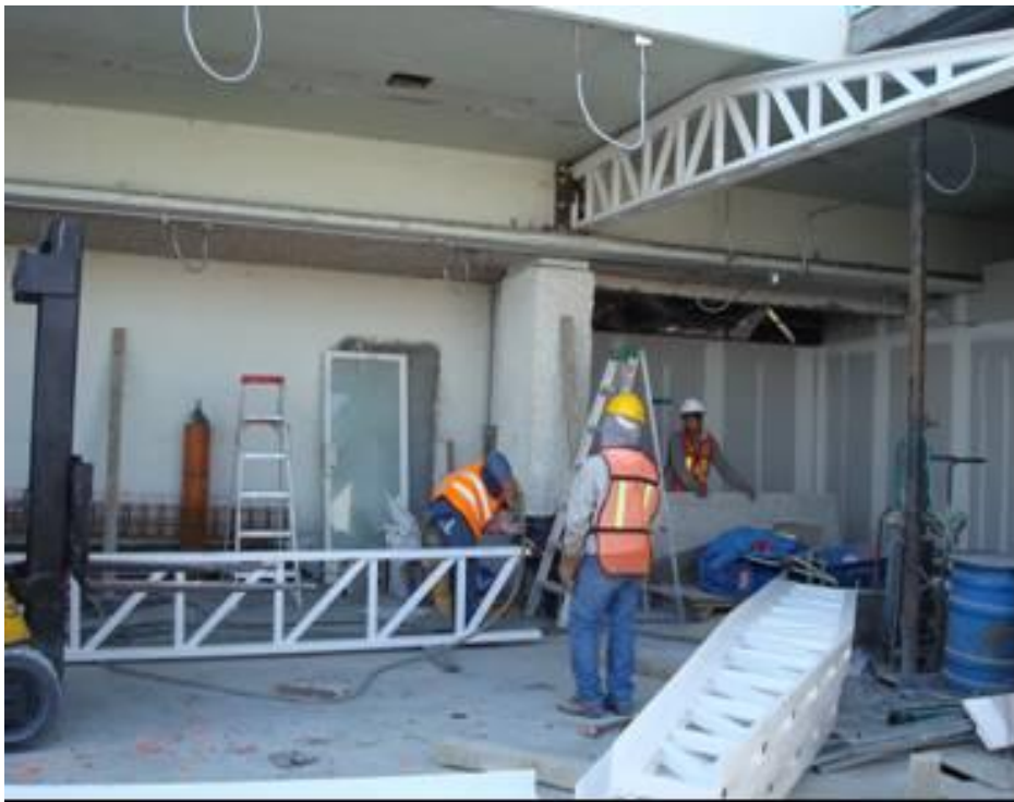
Figura 4.77. Acomodo de montén para la estructura, se ve uno ya instalado y los que están por instalarse apilados (Baselis, 2010)
