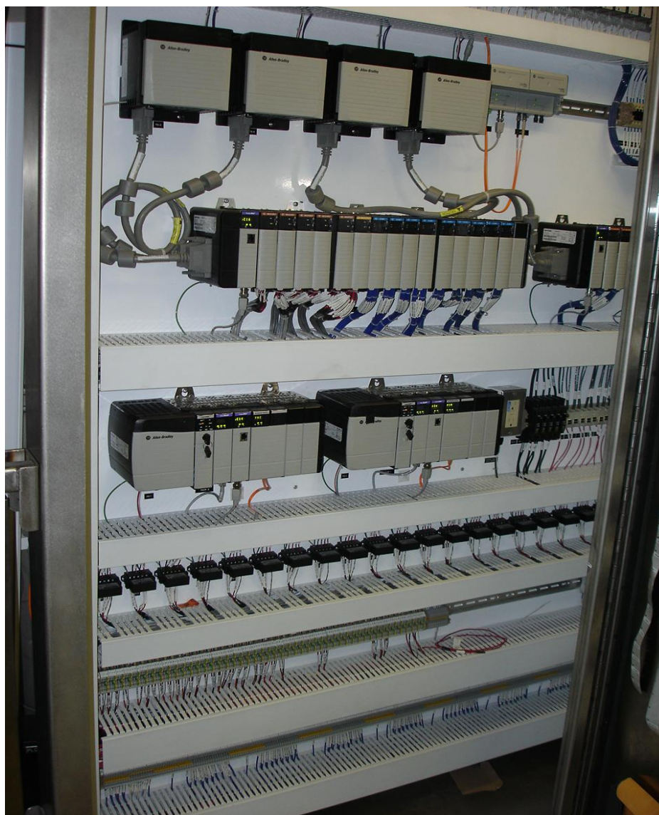
Figura 3.11. Tablero de control que contiene los PLC para el control de las bandas transportadoras (Siemens, 2010)
