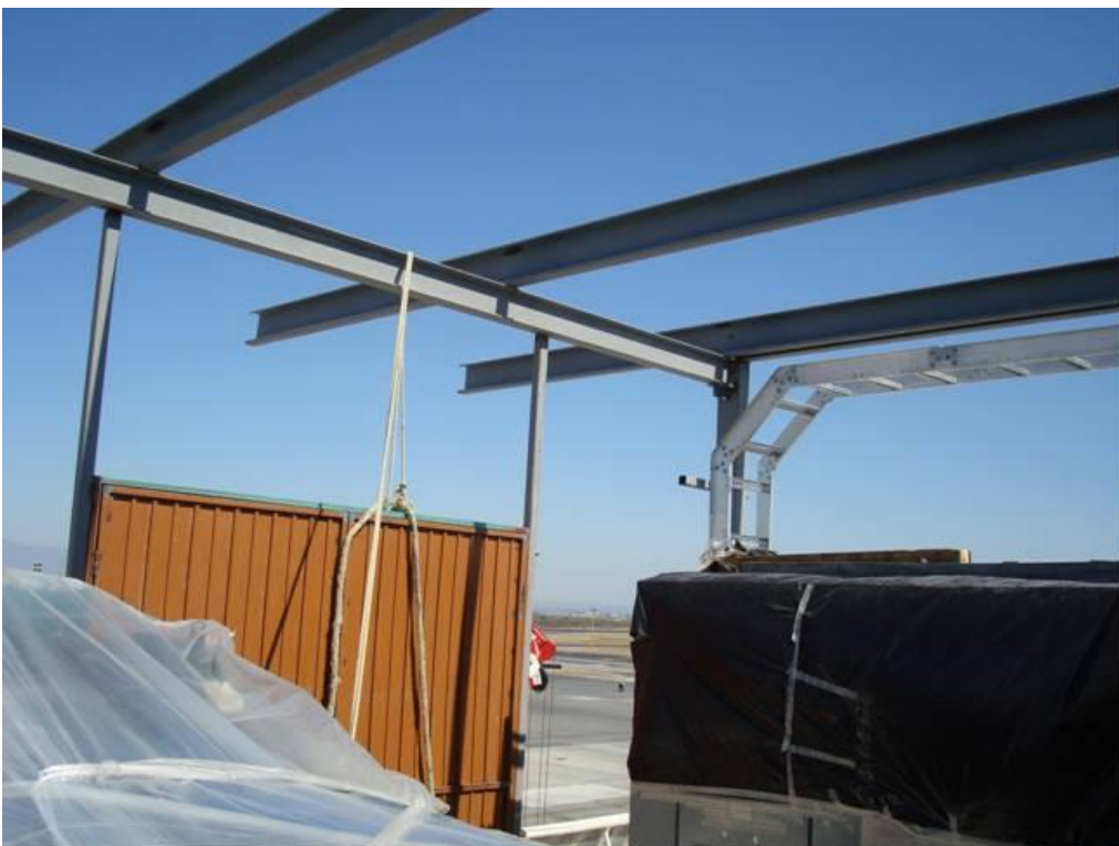
Figura 4.51. Ya colocados los equipos, se procede a cerrar mediante perfiles tipo montén para empezar a colocar los muros de durock (Baselis, 2010)
