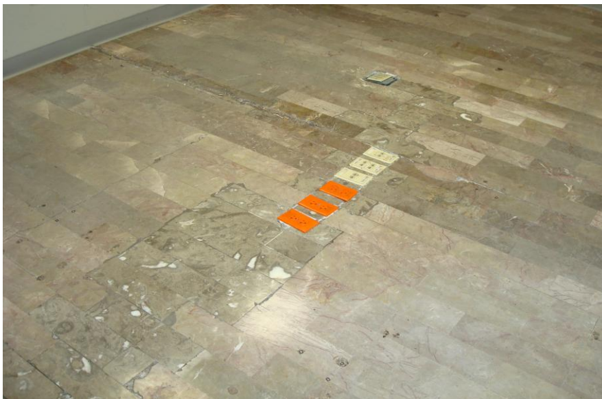
Figura 4.104. Colocación final de accesorios para contactos en piso (Baselis, 2010)
