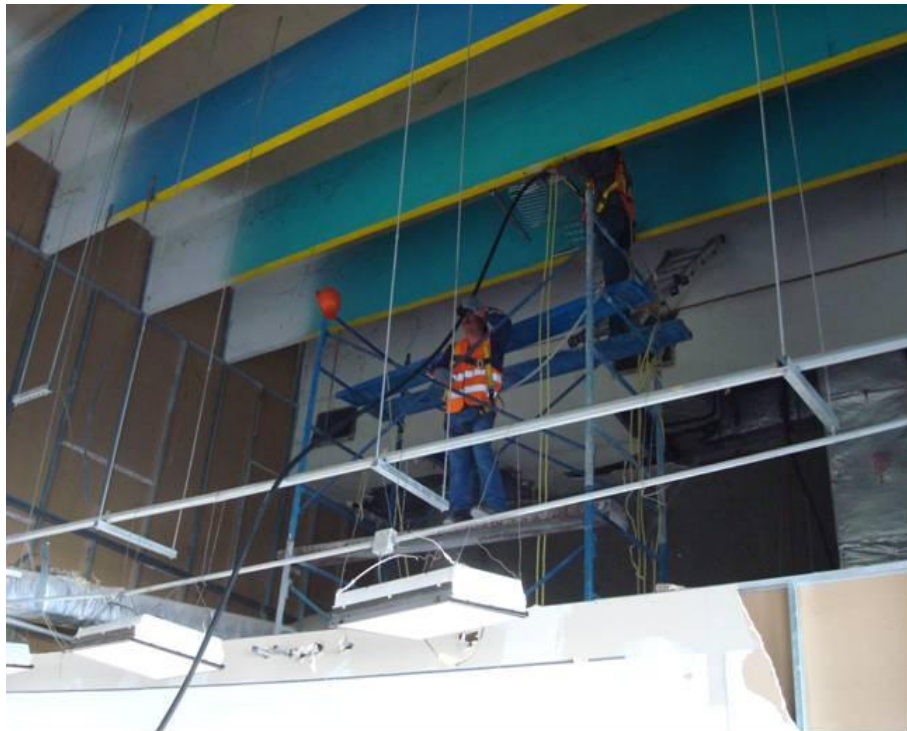
Figura 4.121. Muestra el proceso de cableado para el alimentador más largo proveniente desde la subestación en la azotea (Baselis, 2010)
