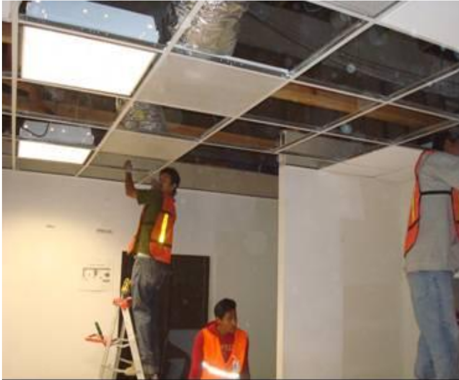
Figura 4.72. Desmantelamiento en zonas de oficinas, incluyendo plafón falso, luminarios y muros varios (Baselis, 2010)
