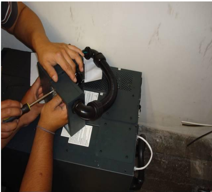
Figura 4.119. Muestra la instalación del equipo UPS de 10 kVA para los servicios de sistemas y del “site” (Baselis, 2010)
