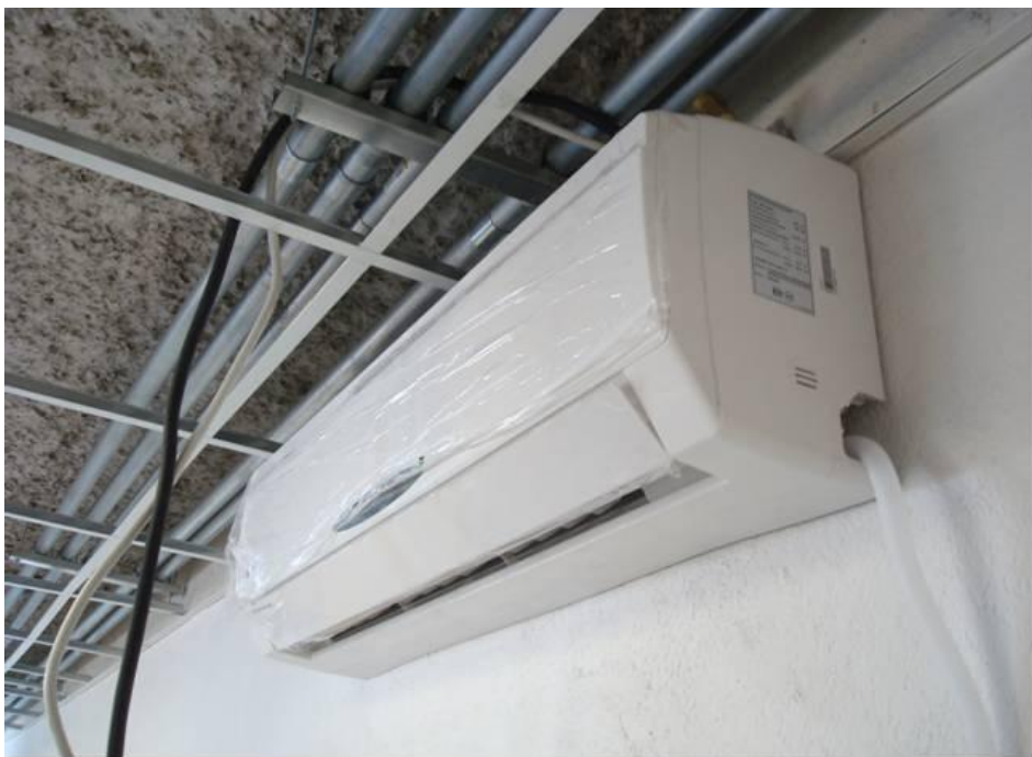
Figura 4.107. Colocación de equipo evaporador, con su refrigeración y alimentación eléctrica (Baselis, 2010)
