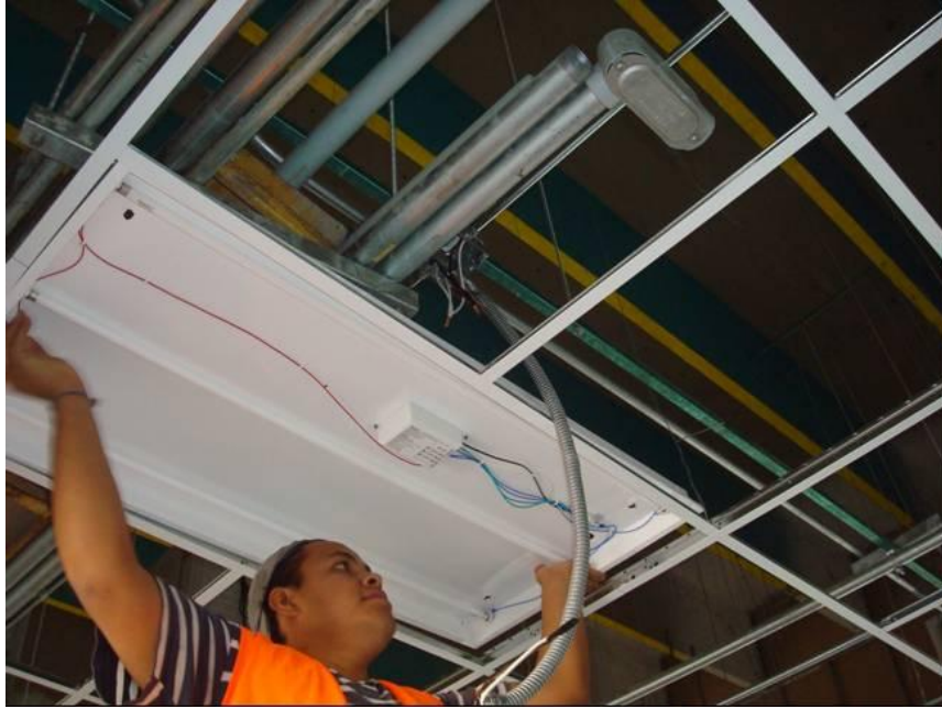
Figura 4.98. Colocación de luminarios fluorescentes empotrados, para el área de las bandas transportadoras (Baselis, 2010)
