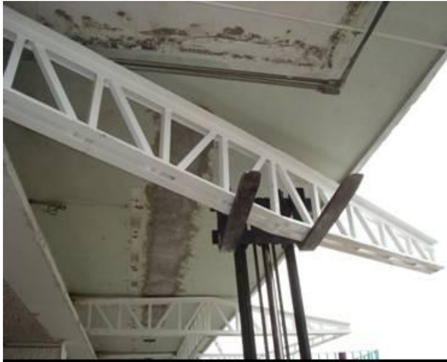
Figura 4.78. Proceso de levantamiento de montén, para su fijación al muro mediante taquetes de expansión (Baselis, 2010)
