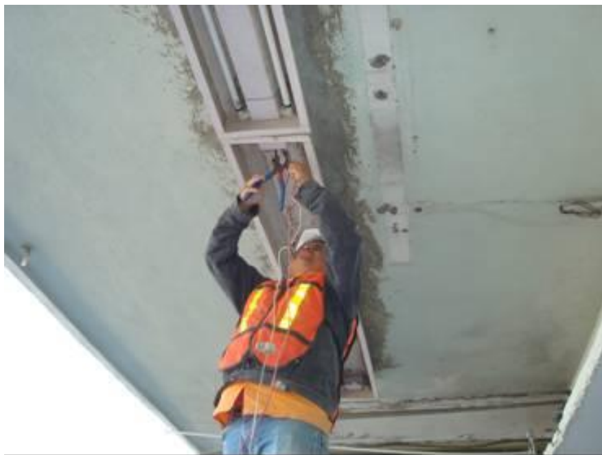
Figura 4.75. Retiro de alumbrado y servicios obsoletos en áreas exteriores de la terminal A (Baselis, 2010)
