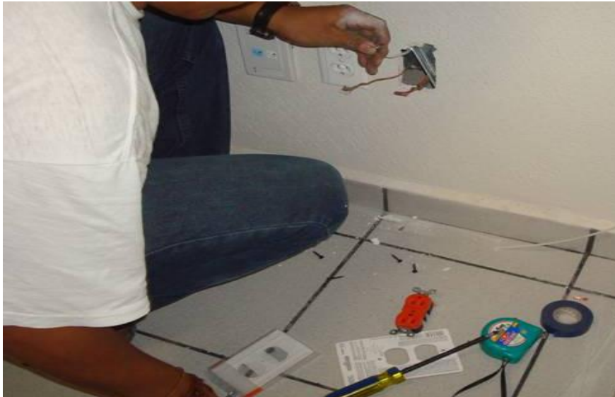
Figura 4.102. Colocación de contactos normales y regulados en muros de tablaroca (Baselis, 2010)
