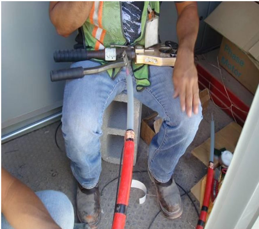
Figura 4.131. Muestra la colocación del cableado en media tensión tipo XLP, para realización de zapatas ponchables y sus aislantes (Baselis, 2010)
