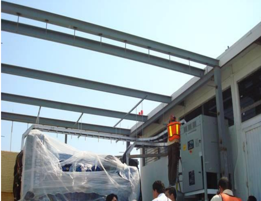
Figura 4.52. Ya colocados los equipos, se procede a la preparación de la canalización eléctrica entre cada uno de ellos (Baselis, 2010)
