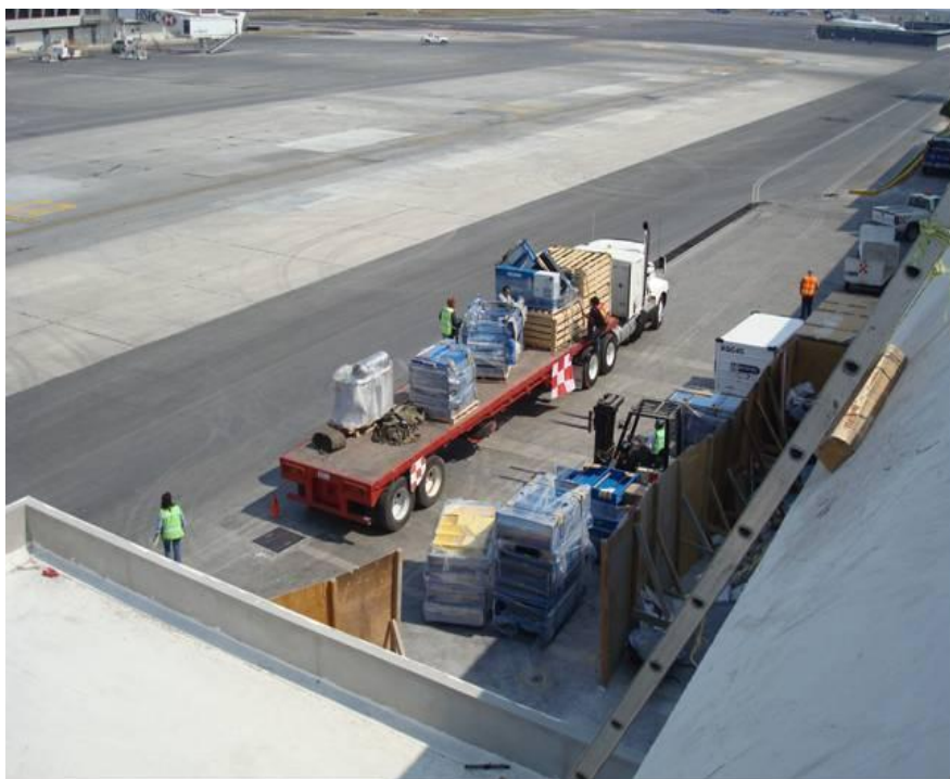
Figura 4.152. Muestra la llegada de los módulos de las bandas transportadoras en transporte de carga (Baselis, 2010)
