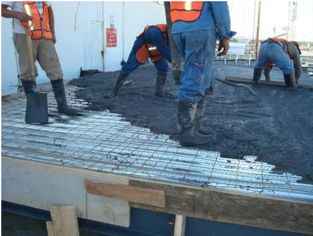
Figura 4.49. Figura que muestra el colado de la loza – acero para el piso de la nueva subestación eléctrica (Baselis 2010)
