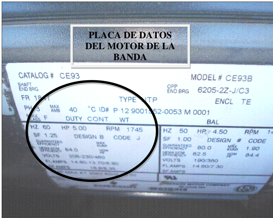
Figura 3.7. Placa de datos de los motores para las bandas transportadoras iniciales (AMTY, 2010)
