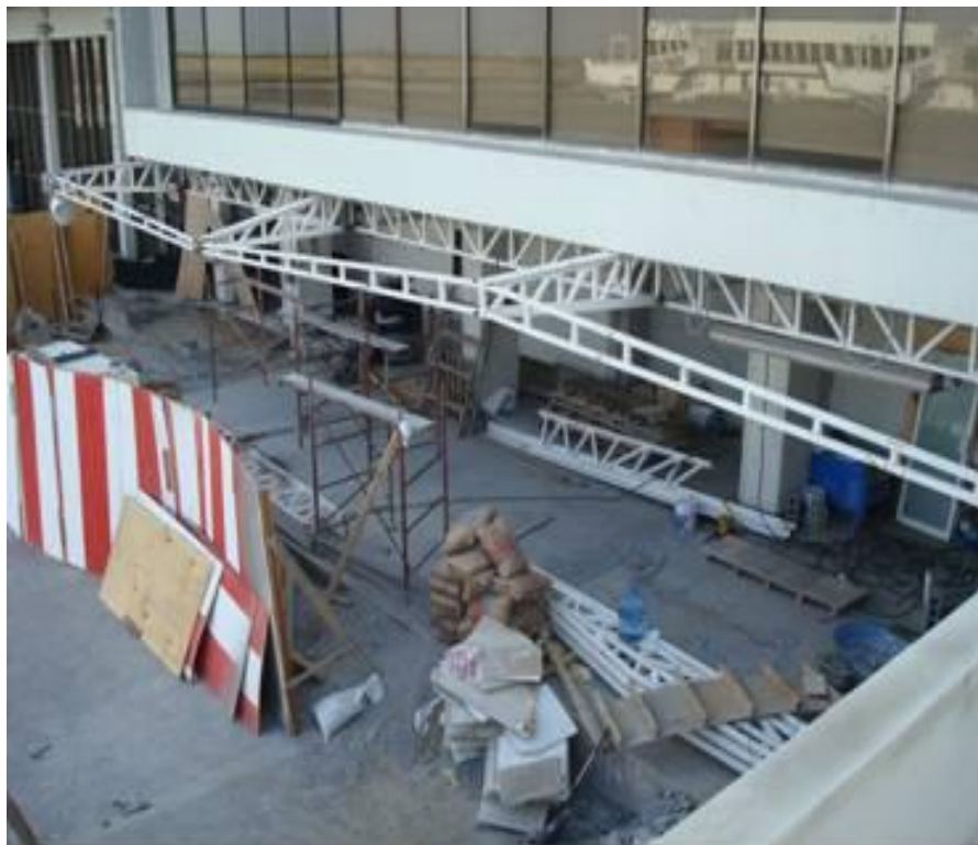
Figura 4.79. Avance general de la colocación de montén en la ampliación de la estructura existente (Baselis, 2010)
