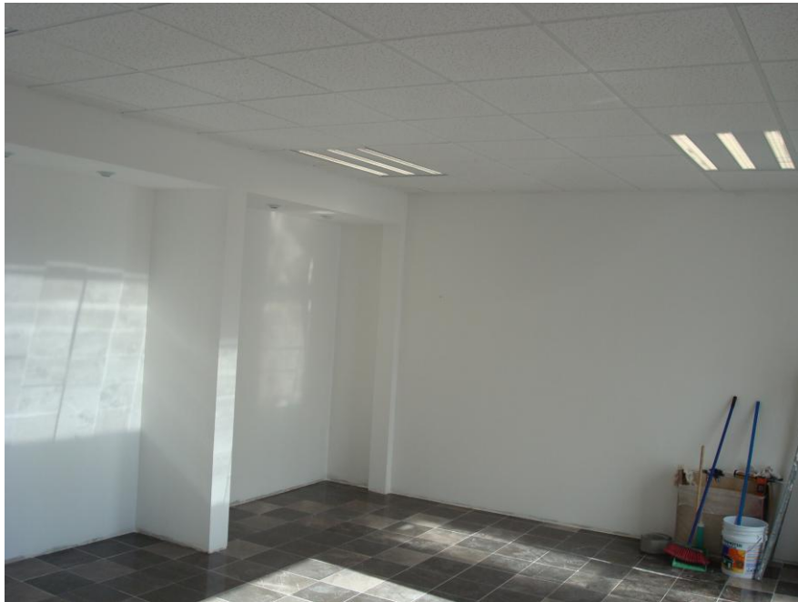
Figura 4.9. Vistas de las paredes, techo y pisos del área en remodelación para una zona agregada a la estructura (Baselis, 2010)
