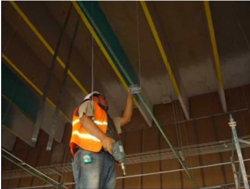
Figura 4.92. Colocación de canalizaciones a la retícula de PTR de soportería general (Baselis, 2010)
