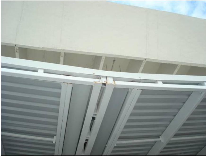
Figura 4.80. Avance general de la colocación de láminas que cubren la estructura y a su vez dan la cubierta de la zona de bandas (Baselis, 2010)
