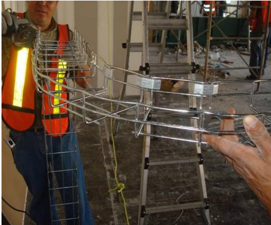
Figura 4.122. Muestra el proceso de manejo de la charola tipo malla, para usarse como canalización de cableado eléctrico (Baselis, 2010)
