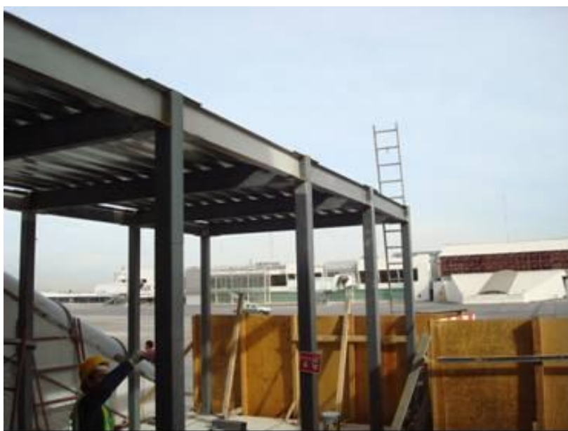
Figura 4.81. Ampliación del cuarto denominado filtro de seguridad de paso hacia plataforma (Baselis, 2010)
