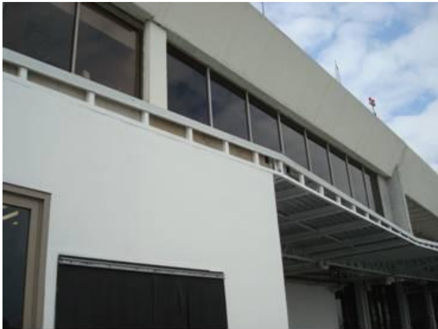
Figura 4.84. Muestra de los acabados para la extensión de las oficinas en ambas zonas de la terminal A (Baselis, 2010)
