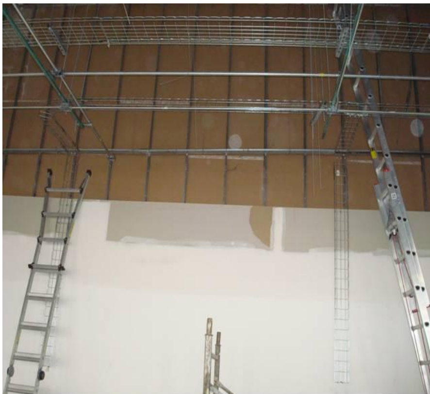
Figura 4.123. Muestra el proceso de colocación de la charola tipo malla, para usarse como canalización de cableado eléctrico (Baselis, 2010)
