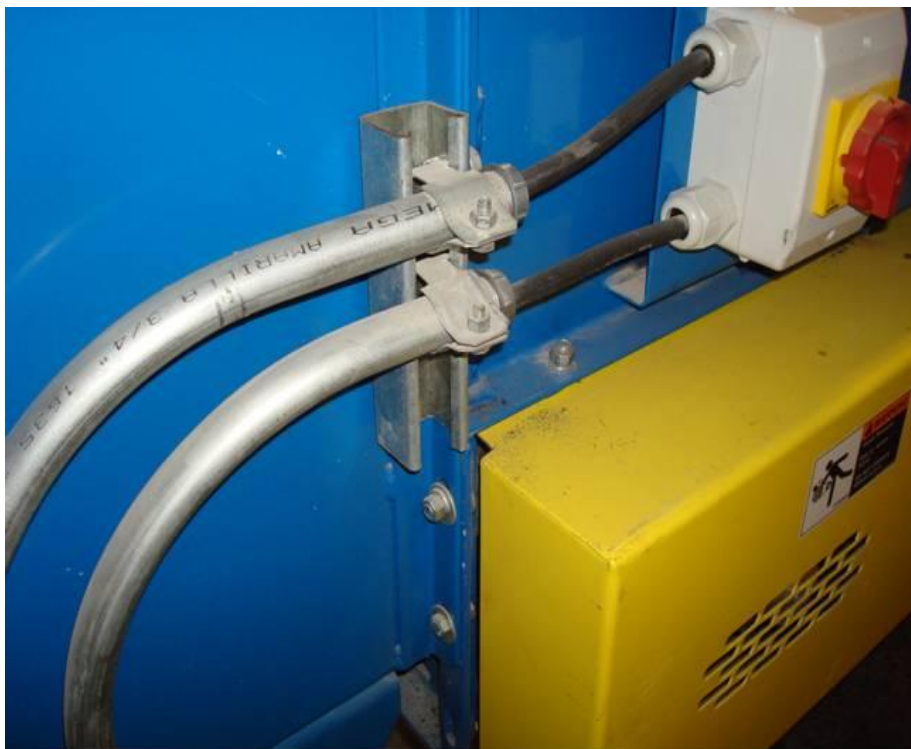
Figura 4.166. Alimentación del botón de paro y control de cada módulo conformante del sistema de bandas transportadoras (Baselis, 2010)
