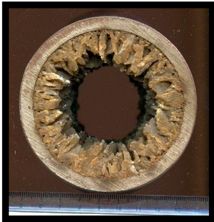
Fig 3.9 Incrustación de Bario en tubería 18
