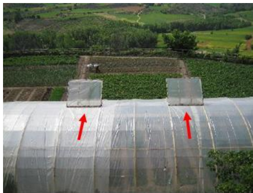
Fig. 2.14 Ventilación pasiva en un invernadero donde se abren las ventanas superiores. 24
