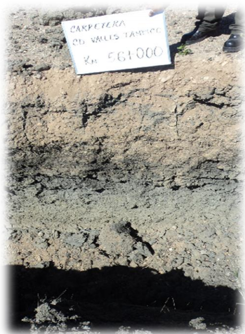
Figura 4.22. Vista "in-situ" del PCA ubicado en el Km 56+000.
