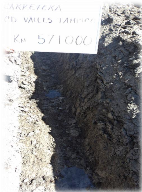
Figura 4.23. Vista "in-situ" del PCA ubicado en el Km 57+000.
