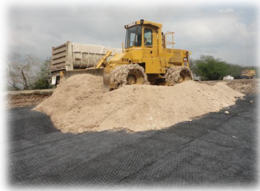
Figura 1.8. Uso de geomalla Triaxl en la modernización de la carretera Ébano – Tampico.
