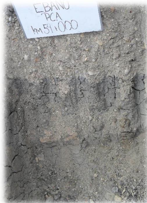
Figura 4.25. Vista "in-situ" del PCA ubicado en el Km 59+000.
