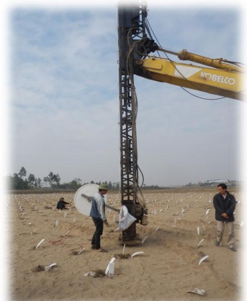
Figura 2.15: Colocación de drenes verticales de arena.
