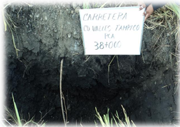
Figura 4.9. Vista "in-situ" del PCA ubicado en el Km 38+000. Fuente: Secretaría de Comunicaciones y Transportes.
