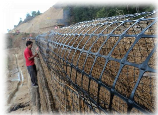
Figura 1.7. Colocación de geomalla tipo biaxial en la fachada del muro mecánicamente estabilizado en el Libramiento de Jalapa, Veracruz.
