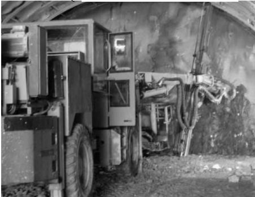
Figura 28.- Barrenación Horizontal de 3.4 m
