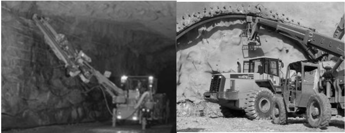
Figura 31.- Colocación de Anclajes y perforación de Drenaje y Colocación de Marcos metálicos
