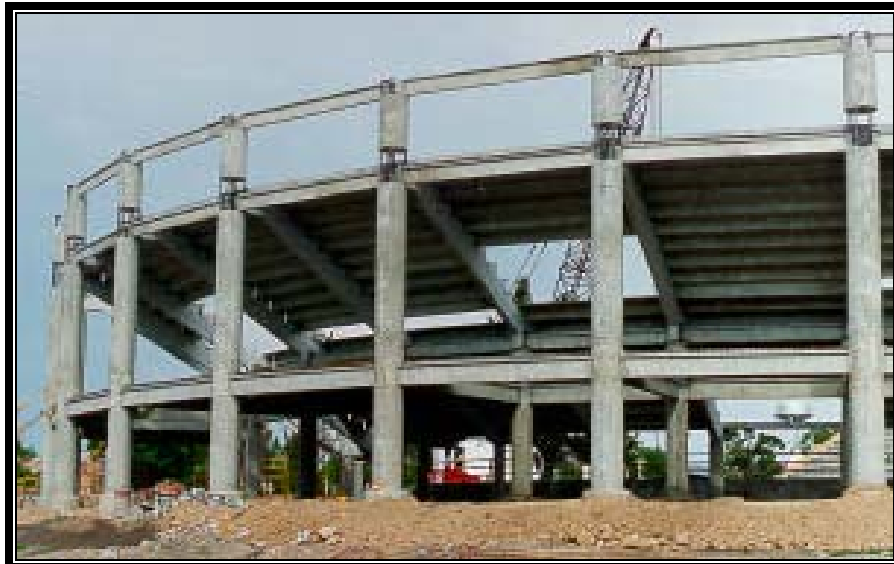
Figura 2.47 Columnas circulares Gradass Lienzo Charro Morelia, Michoacán.
