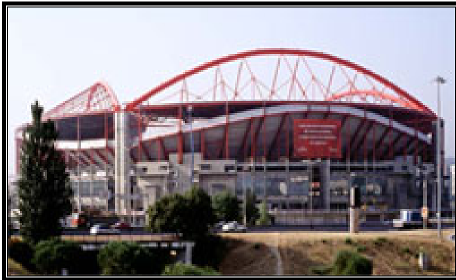
Figura 2.33 Arcos de acero sobre pilares angulares.
