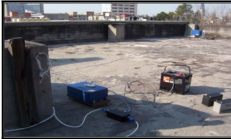
Figura 4.3.4. Medición de señales.
