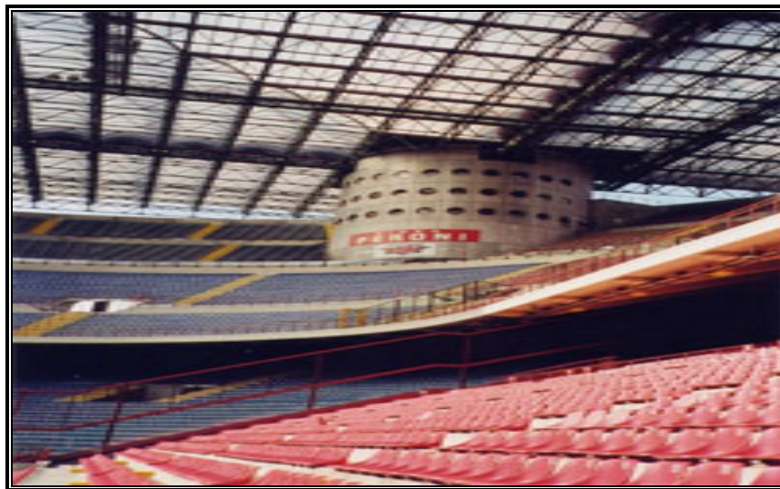
Figura 2.23 columnas de soporte de gradas y techo.
