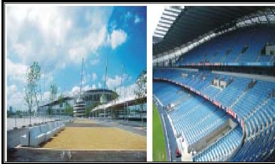
Figura 4.4.2 Vista exterior del Estadio.
