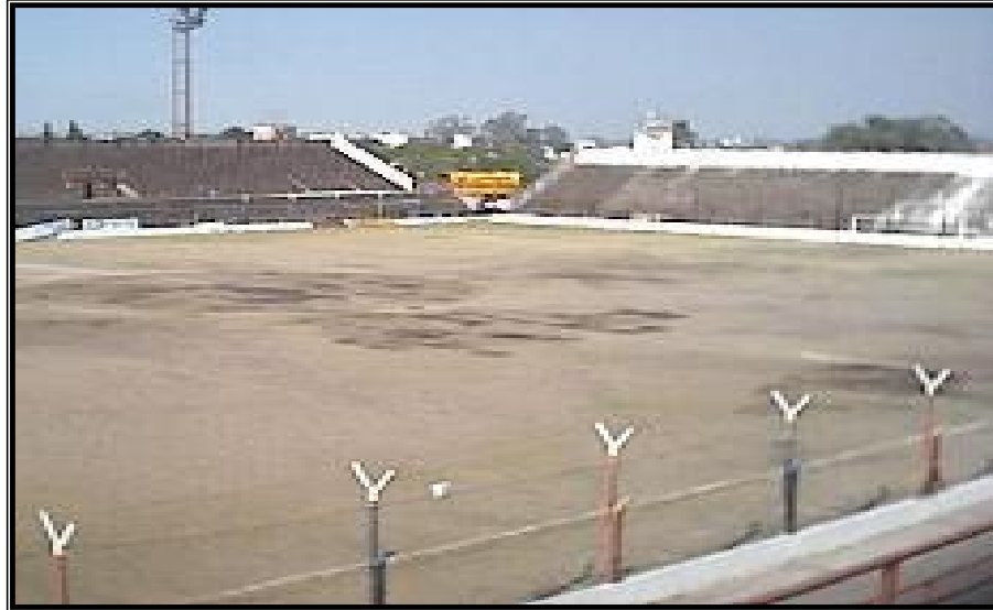
Figura 2.1. Estructura del estadio Huracán Corrientes – Argentina.
