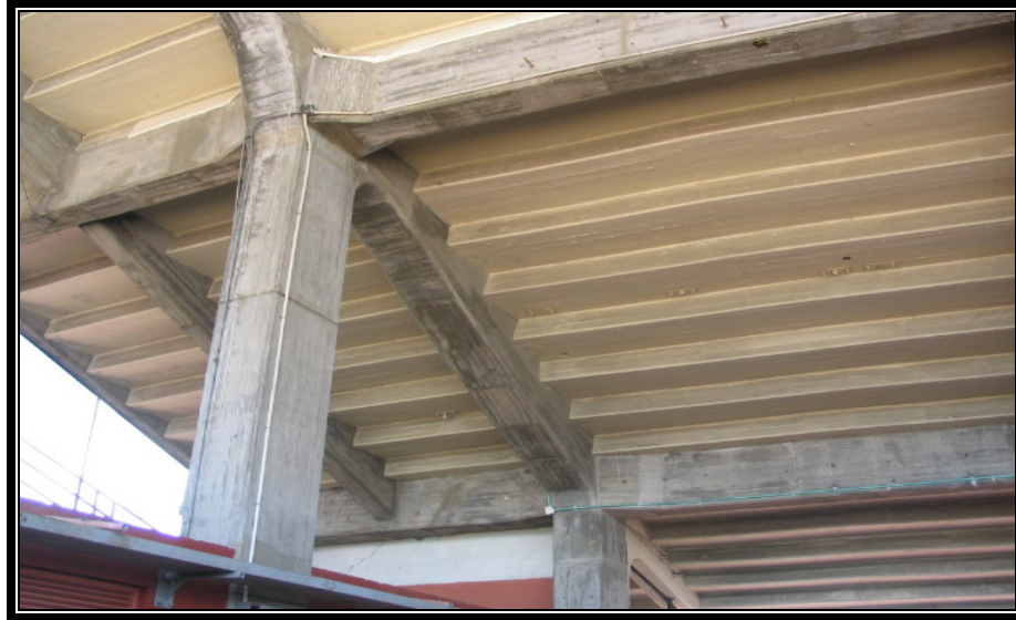
Figura 2.59. Reforzamiento de Tribunas Norte y Oriental.
