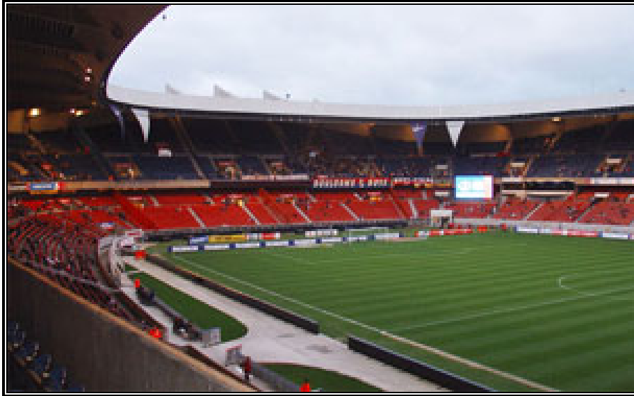
Figura 2.42 Vista del interior del Estadio de los Principes Francia.
