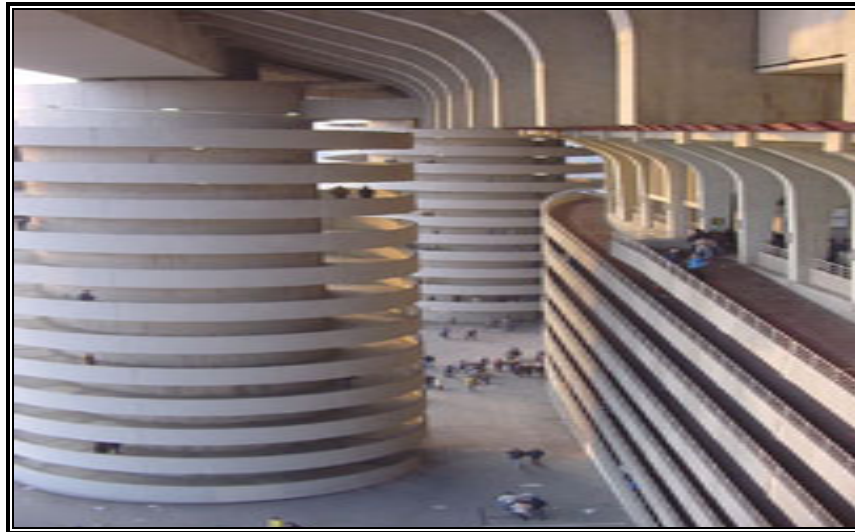
Figura 2.22 Torres cilíndricas de concreto armado.
