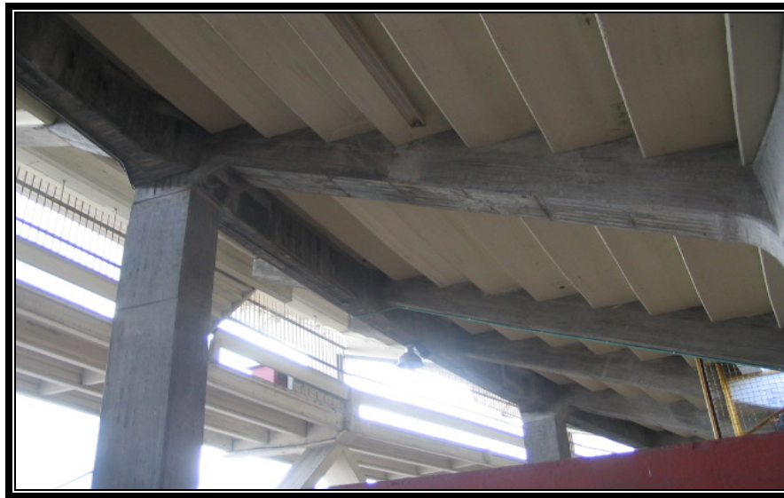
Figura 2.60. Reforzamiento de las tribunas sur.
