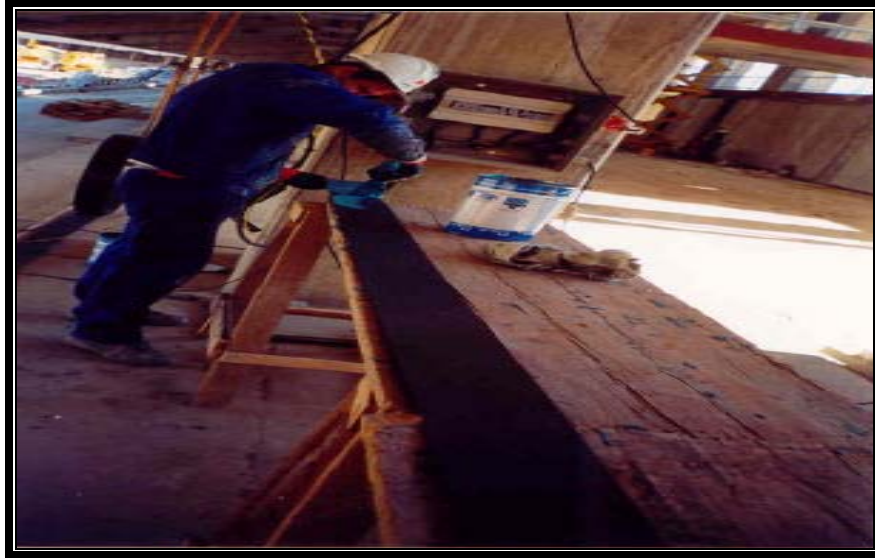
Figura 2.65 Aplicación de adhesivo.
