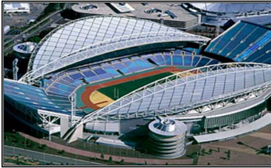
Figura 2.34 Tribunas cubiertas por una gran cubierta.
