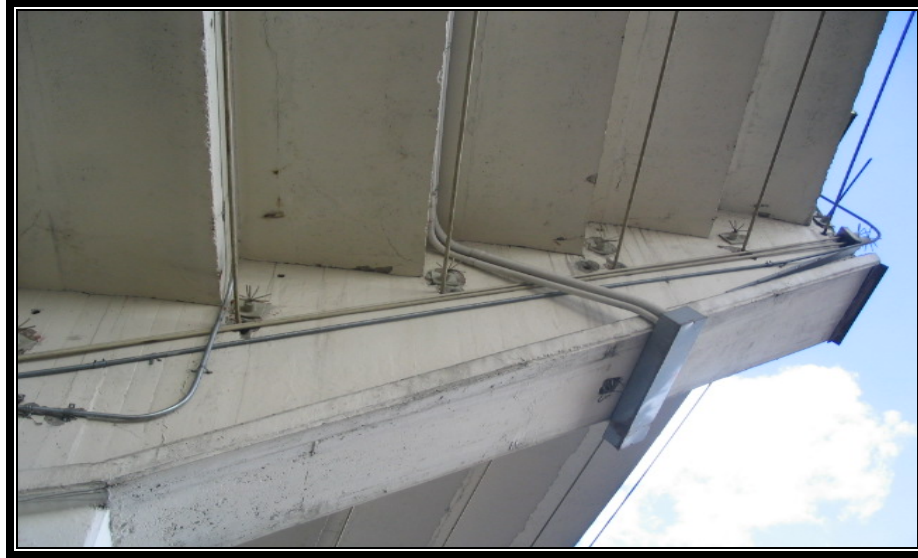
Figura 2.57. Reforzamiento de la estructura con cables de postensado.
