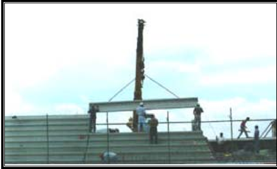
Figura 2.48 Montaje de tribunas estadio Brujos Gto. México.
