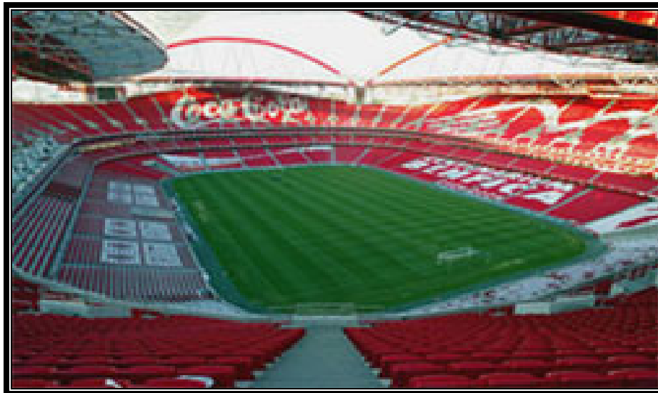
Figura 2.31 Vista interior del Estadio de la Luz.
