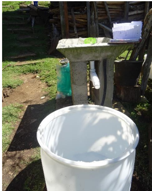
Figura 3.19 Batea con céspol y primer tambo (Elaboración propia, 2019)
