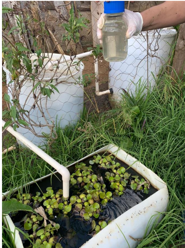
Figura 3.32 Reservorio de aguas grises tratadas del filtro de Don César (Elaboración propia, 2019)
