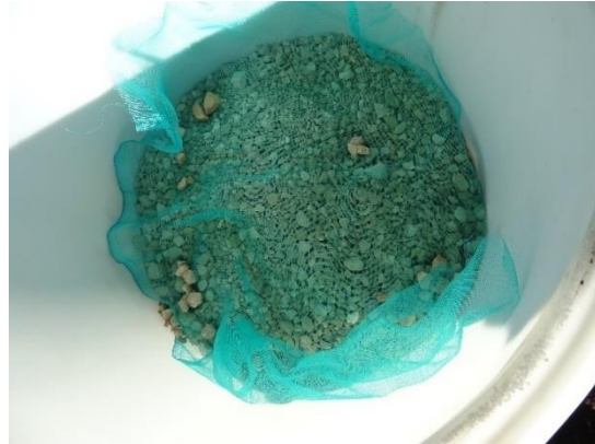
Figura 3.23 Segunda capa de grava con malla mosquitera (Elaboración propia, 2019)
