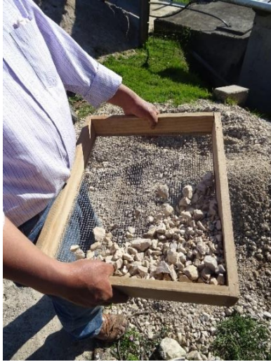
Figura 3.22 Grava cribada para segunda capa (Elaboración propia, 2019)
