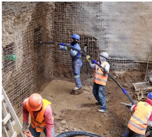
Figura 4.7: Cuadrilla insertando los torones en el barreno. En la figura se pueden observar los centradores en color azul.
