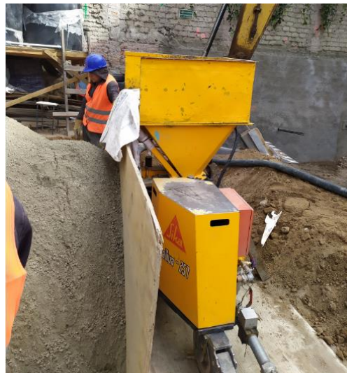
Figura 4.9: Lanzadora de concreto.
