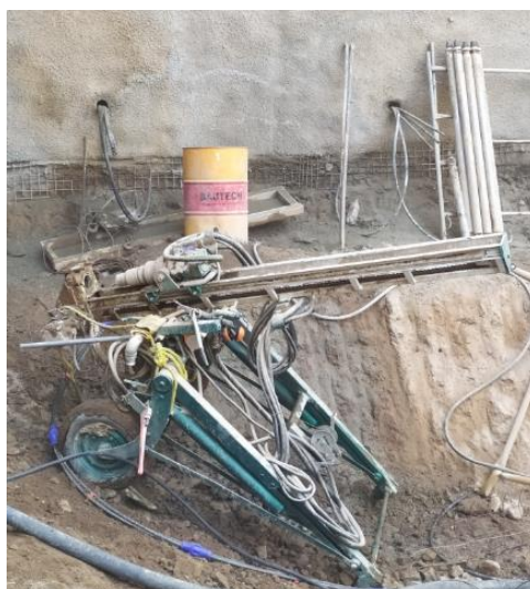
Figura 4.6: Perforadora neumática en el fondo de la excavación (11.5 m). En la parte superior de la foto se pueden apreciar las barras de perforación.
