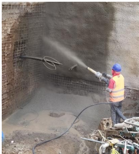
Figura 4.10: Lanzado de concreto vía seca.
