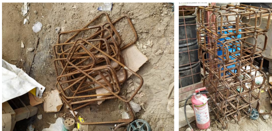
Figura 4.3: Anillos de varilla y armado de zapatas de reacción.
