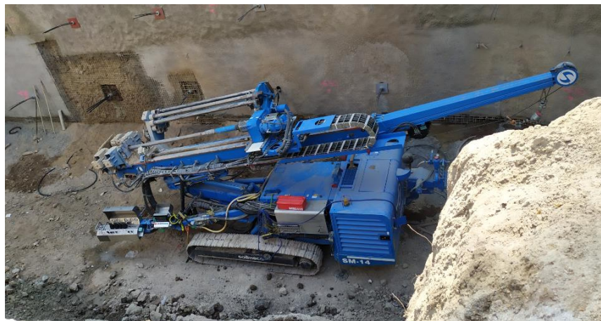
Figura 4.5: Perforadora hidráulica en el fondo de la excavación, que en ese momento tenía una profundidad de 7.5 m.
