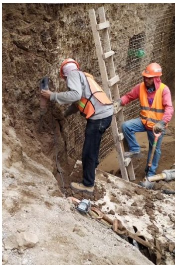
Figura 4.2: Perfilado del terreno.
