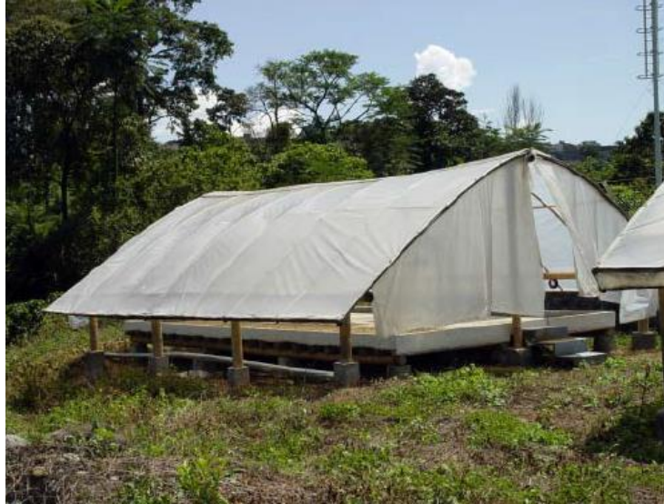
Figura 14. Configuración de secador de café solar de tipo parabólico (Caballero Pérez Juan Francisco, 2015)
