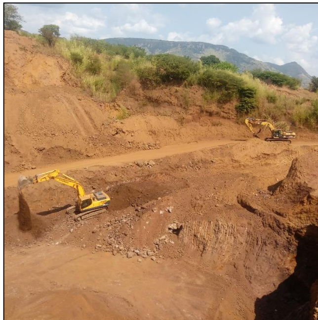
Construcción de rampa principal.
