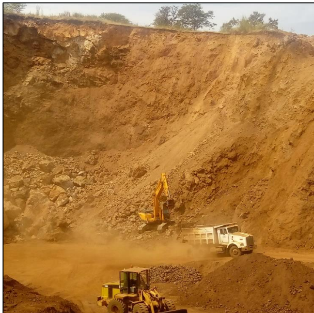
Acarreo de material tumbado por el terremoto.
