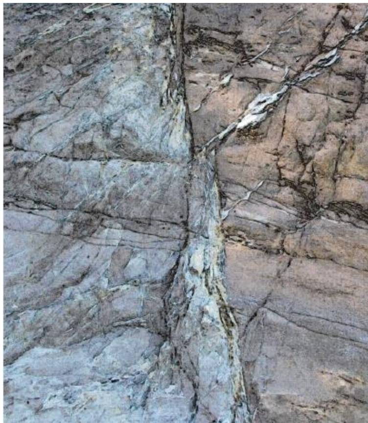
Figura 38 Una falla en un afloramiento (Schlumberger, 2005)
