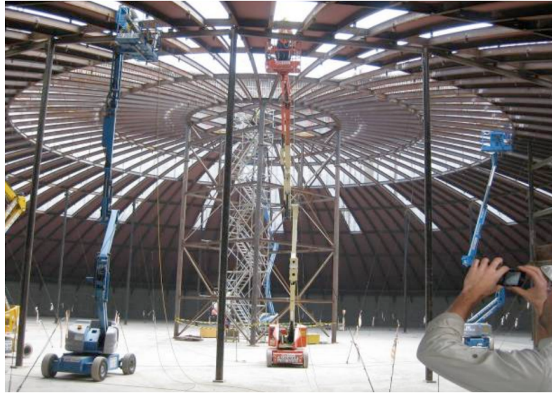
Imagen 19 .- Cúpula vista desde el interior del tanque.
