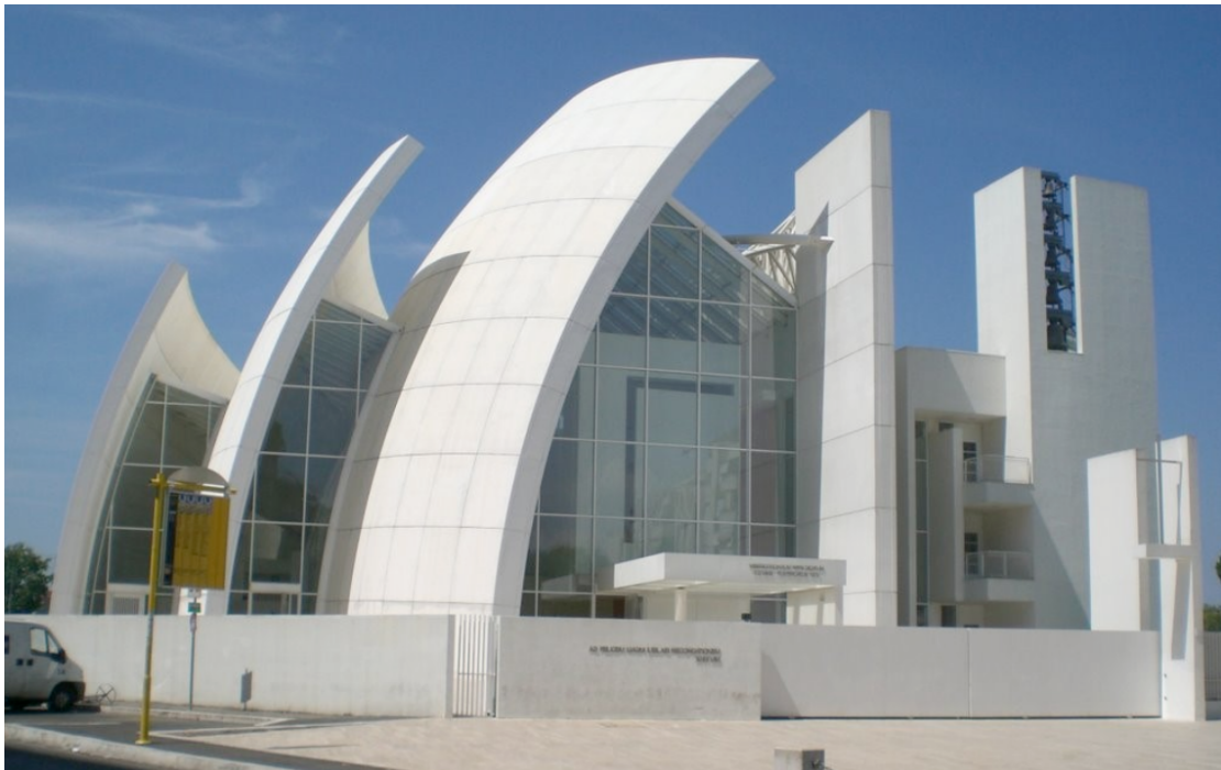
Imagen 1.- Concreto auto limpiable con nano partículas de \text{TiO}_2 . Iglesia Jubilar en Roma.
