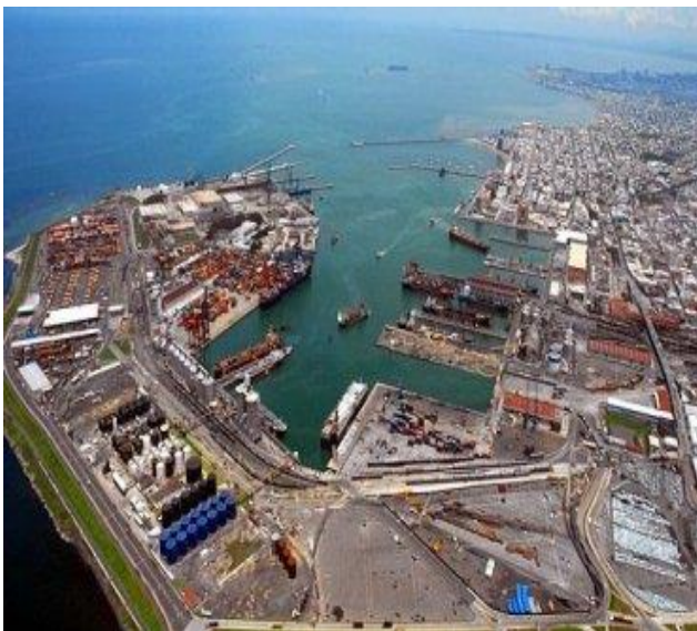
Figura 5. 2. 4. Distribución actual del Puerto de Veracruz revisión de sus mercancías a través de equipos de Rayos Gamma, Rayos X y control de accesos y cámaras de circuito cerrado.
