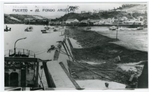
Figura 3. 7. Puerto Chile destruido por efectos de resonancia
