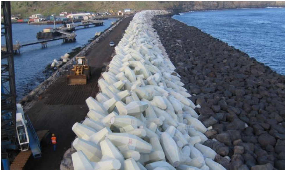
Figura 3. 10. Construcción de coraza de rompeolas con Core-Loc
