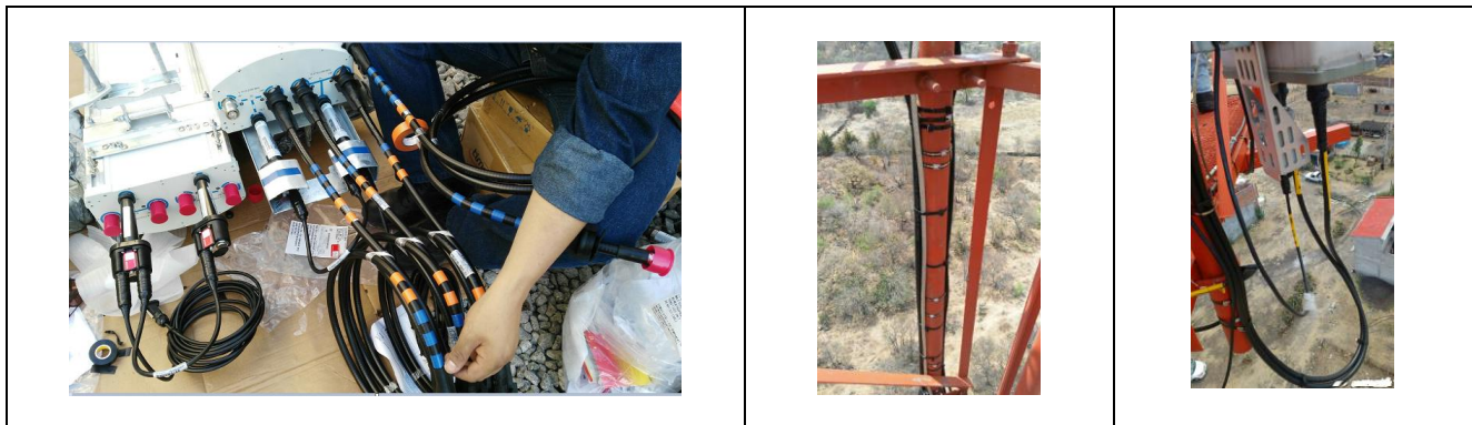
Figura B 74. Instalación de Jumpers.
