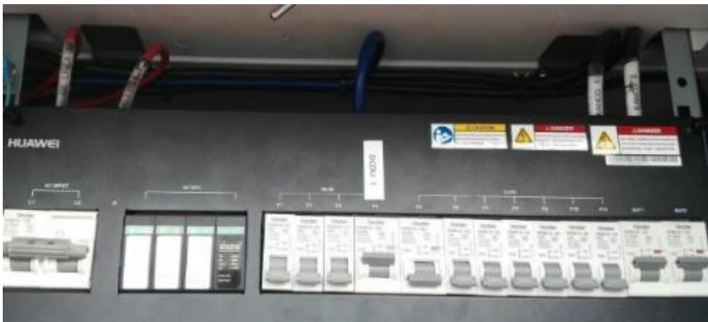
Figura B 37. Identificación de posición en Breaker DCDU1.
