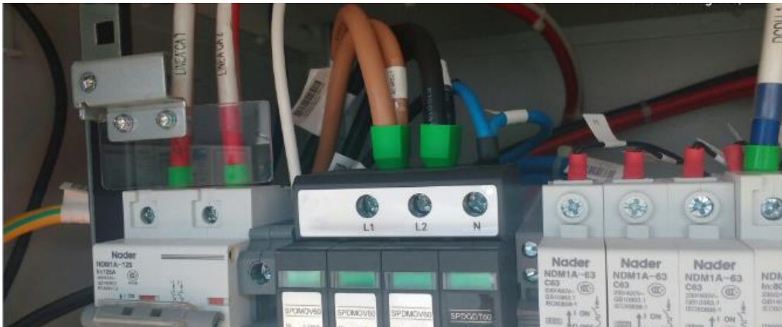
Figura B 22. Posición de Fase 1, Fase 2 y Neutro en gabinete TP48200.
