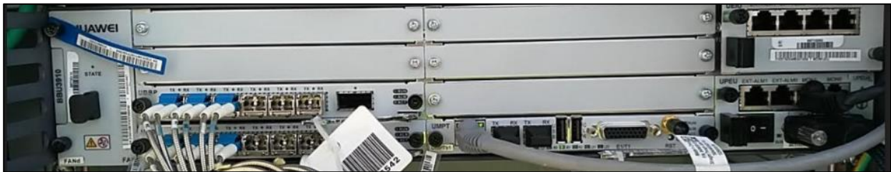
Figura B 46. Posición de la tarjeta UMPT en la BBU.
