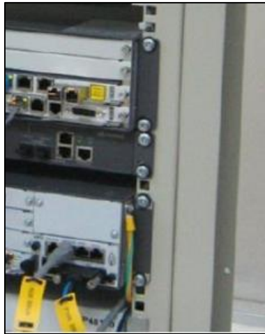
Figura B 33. Puesta a tierra de BBU.
