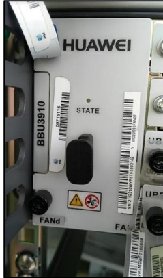
Figura B 45. Posición de FAN en la BBU.
