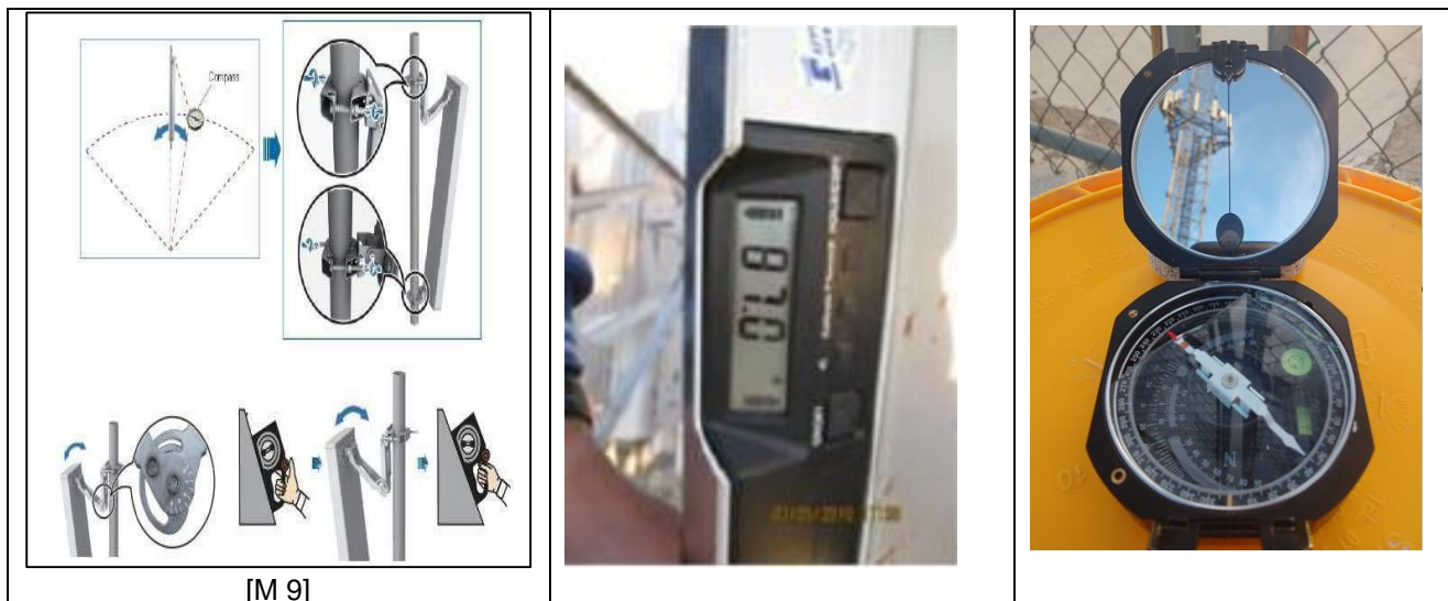
Figura B 66. Inclinación y orientación de antena.
