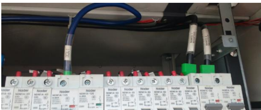
Figura B 38. Conexión DCDU cable color Azul. Etiqueta DCDU1.
