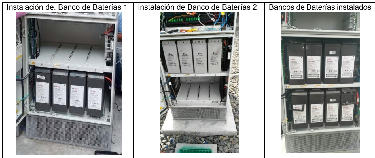
Figura B 13. Instalación de banco de baterías.
