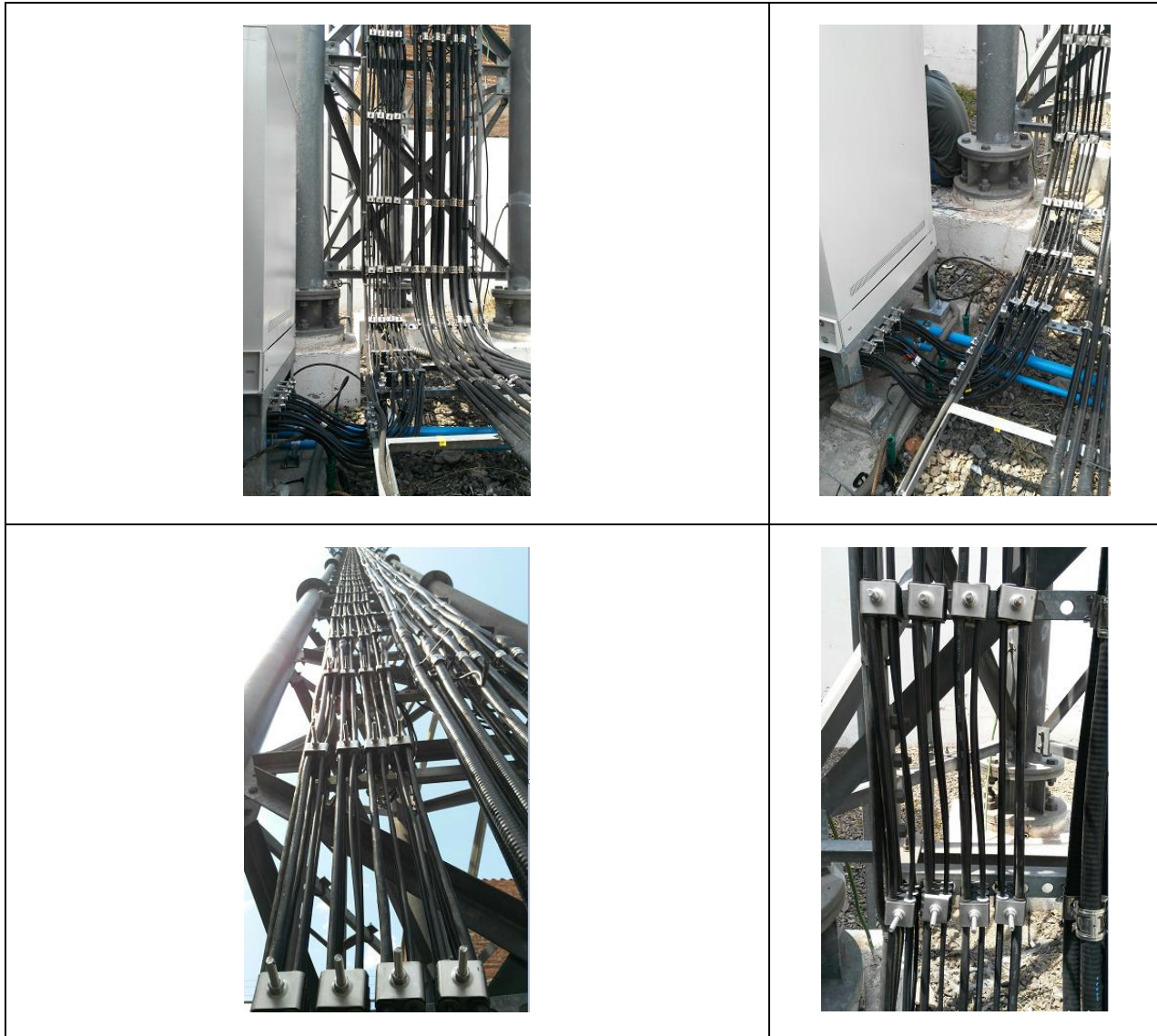
Figura B 54. Instalación de cable de fuerza DC y FO en escalerilla horizontal / vertical (Outdoor).
