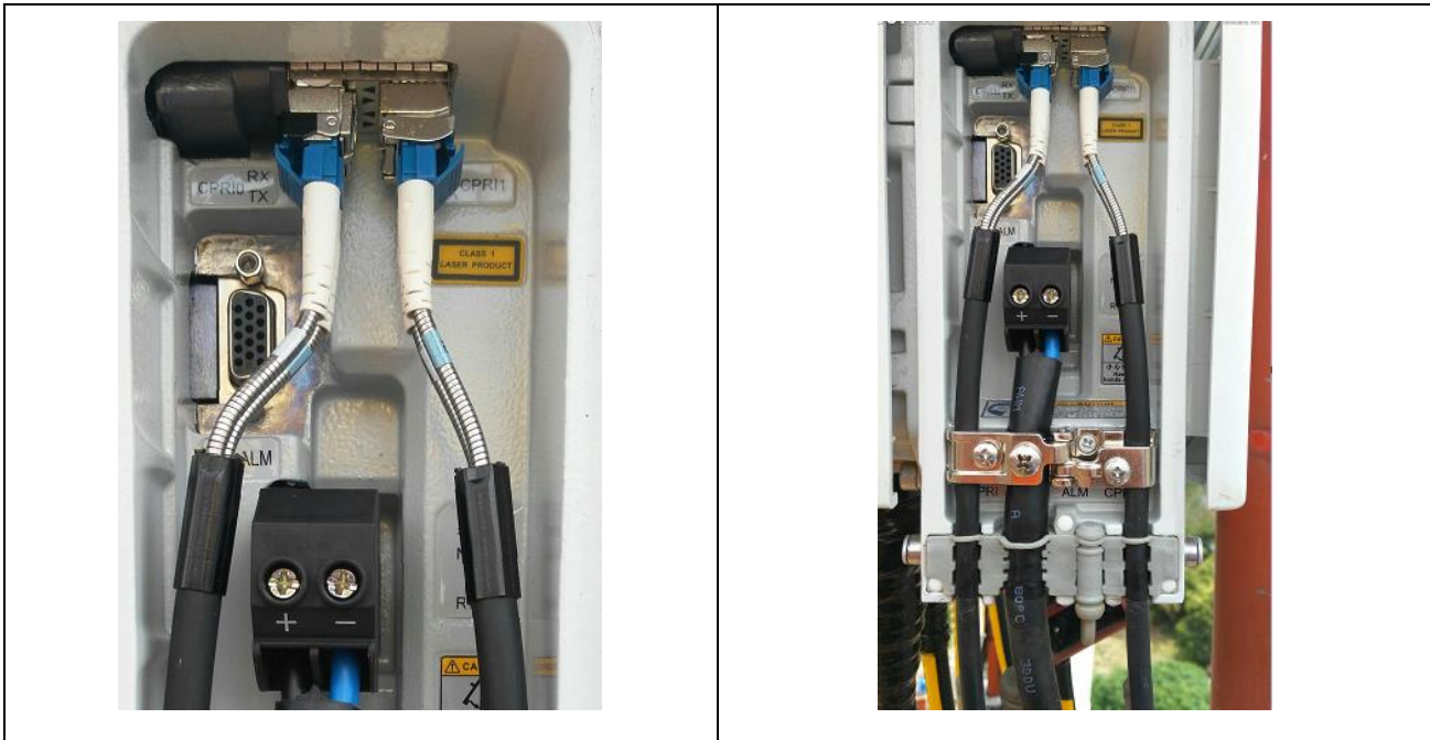
Figura B 60. Instalación de fibra óptica en RRU.
