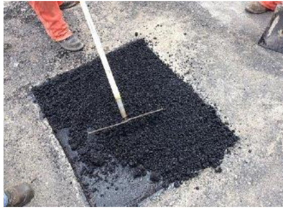
Fig. 2-16 Reparación de baches (Rangel Galicia, 2015)
