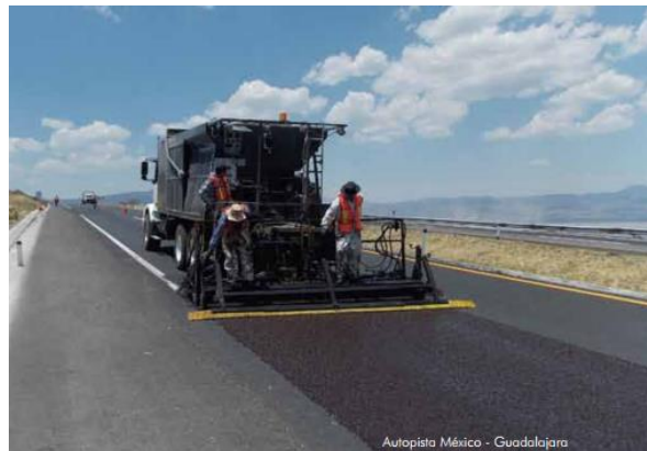
Fig. 2-17 Colocación de mortero asfaltico (ALTEA, 2014)
