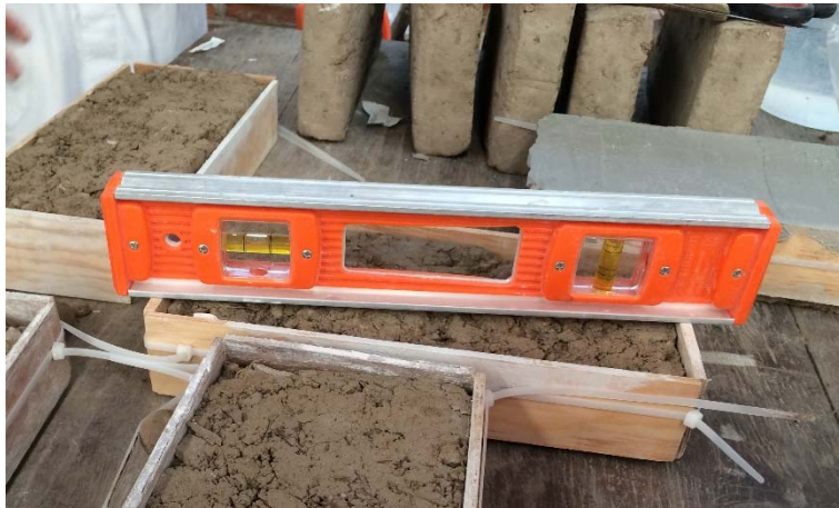
Figura 91. Nivelación de encofrado
