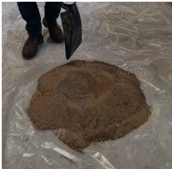
Figura 75. Mezcla de materiales en seco
