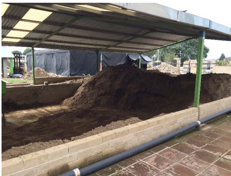
Figura 51. Material de excavación
