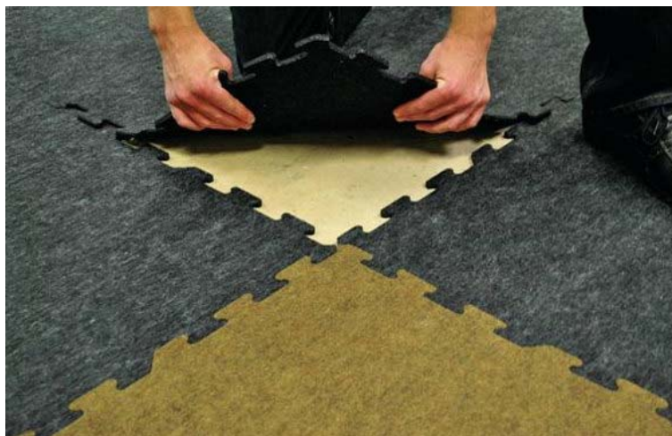
Figura 23. Colocación de suelos ecológicos ECORE
