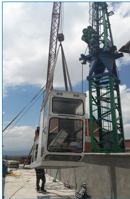
Figura 5.20. Retiro de la caseta de operación. Fuente: Arq. Michel Tomé Toriz.
