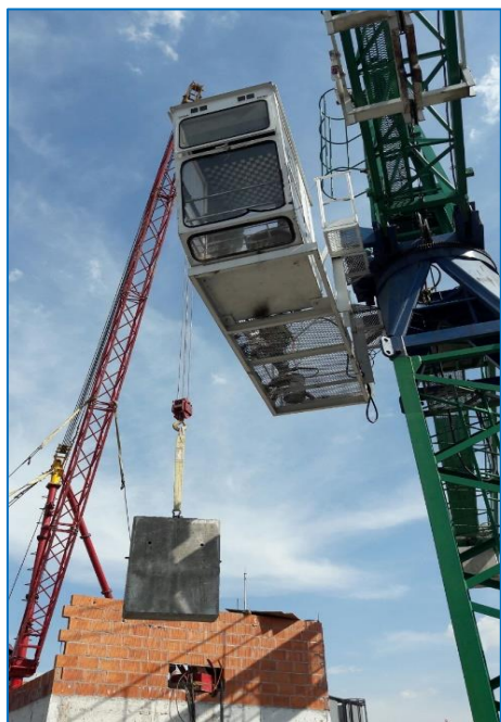
Figura 5.17. Desmontaje de contrapesos de equilibrio. Fuente: Arq. Michel Tomé Toriz.
