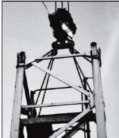
Figura 4.6.1.3. Sujeción correcta de elementos verticales.
