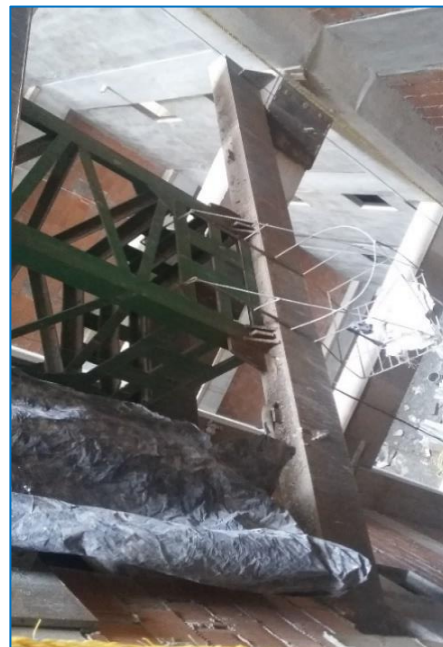
Figura 5.4. Fijación de la torre inferior de la grúa. Fuente: Arq. Michel Tomé Toriz.
