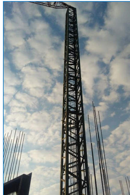
Figura 5.6. Apilamiento de la torre. Fuente: Arq. Michel Tomé Toriz.
