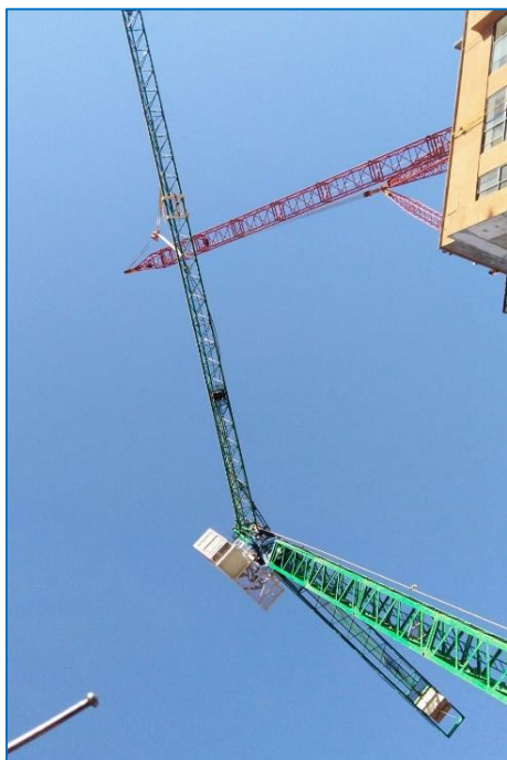
Figura 5.11. Colocación de la pluma. Fuente: Arq. Michel Tomé Toriz.
