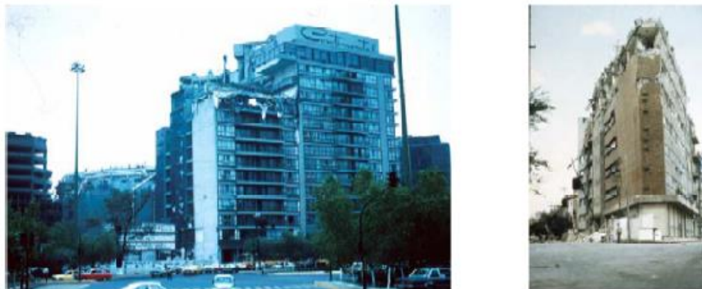
Figura 1-1 Daños en pisos superiores, Septiembre de 1985, Ciudad de México (Terán, Díaz y Arroyo, 2014)
