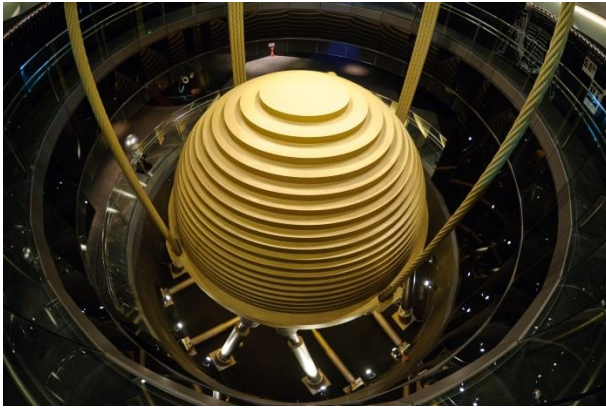
Figura 1-5 Sintonizador de Masa del Edificio Taipei 101. Imágenes tomadas del sitio: http://www.taipei-101.com.tw/en/observatory-damper.aspx
