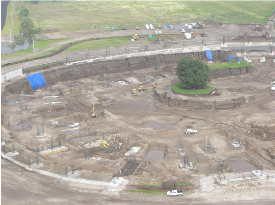
Figura III.53 Relleno fluido en Zapatas Combinadas en parte del estadio.
