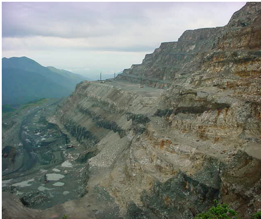
Figura 3 Extracción a cielo abierto. INSTALACIONES DEL CMBJPC.
