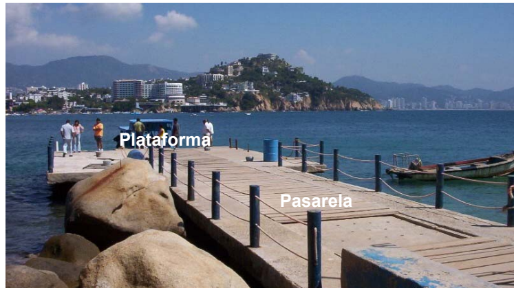
Figura. 3.4.- Vista del muelle existente en la Roqueta
