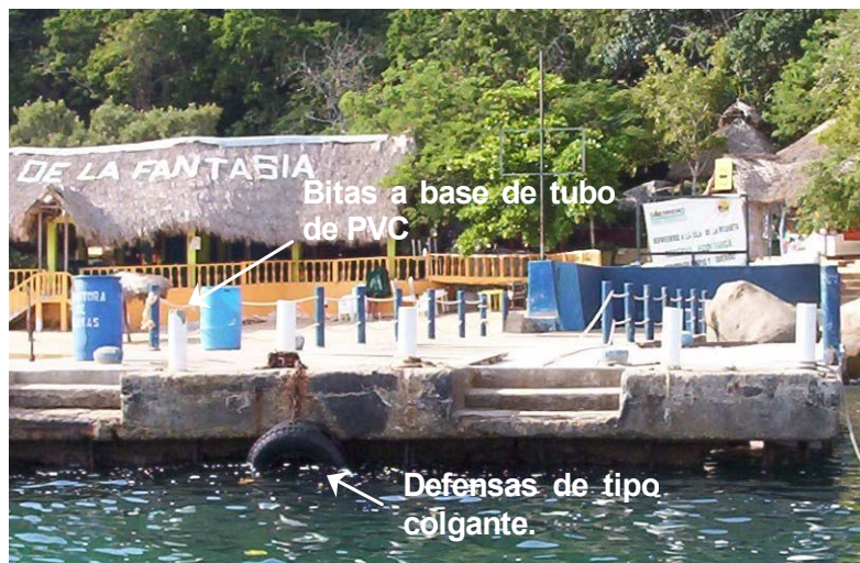
Figura. 3.5.- Vista frontal del muelle
