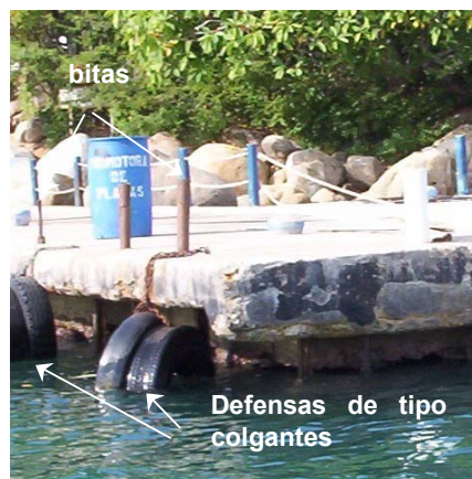
Figura. 3.7.- Elementos de protección del muelle
