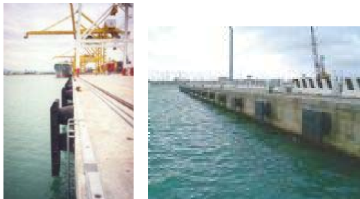
Figura. 2.14.- Defensas de atraque fijas rectangulares
