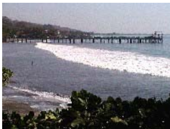
Figura 2.8.- Imagen de muelle apoyado en pilas.
