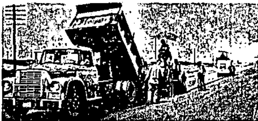
Fotografía 2, Trabajando en un carril ya escarificado y regado con agente rejuvenecedor, los pavimentadores del Distrito tienen espesores de 1.7 a 2.0 cms.
