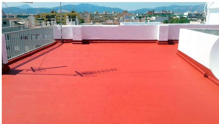
Figura 32. Ejemplo de techo impermeabilizado
