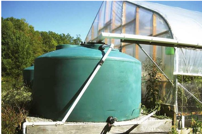
Figura 11. Sistema de captación para usos agrícola. Fuente: IICA
