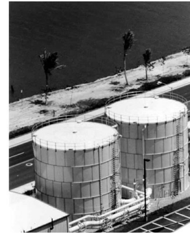
Figura 1.13 Fotografía de tanques con succión positiva.
