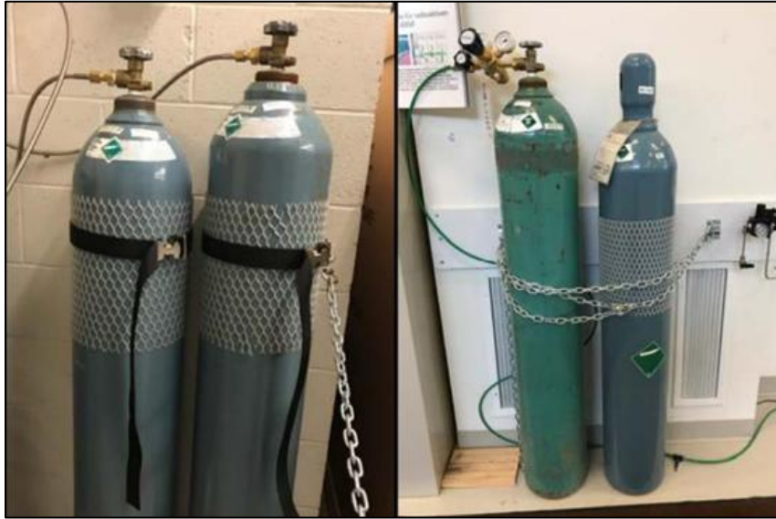
Figura 2. Protección contra daños mecánicos: Las correas de nailon o las cadenas aseguran que un cilindro no se caiga. Cuando un cilindro no está en operación, almacenado o en tránsito, se debe usar una tapa de protección de la válvula, tal como se muestra en el último cilindro a la derecha.
