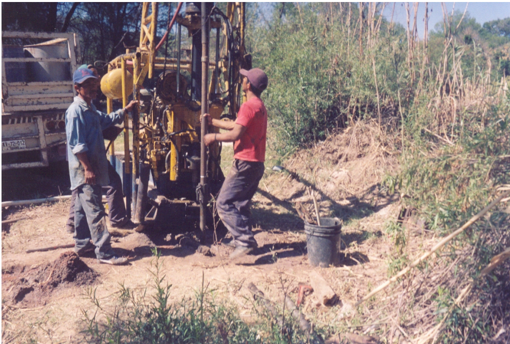
FOTOGRAFIA N° 3: DEL SONDEO SE - 2.
