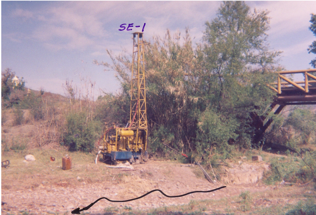
FOTOGRAFIA N° 2: DEL SONDEO SE - 1.
