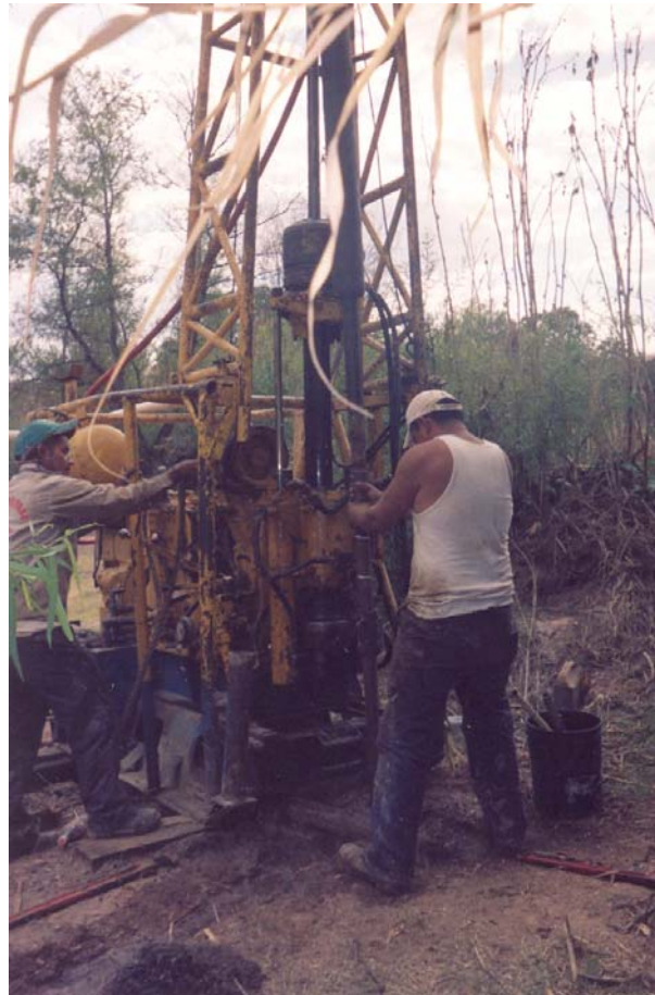
FOTOGRAFIA N° 1: DEL SONDEO SE - 1.
