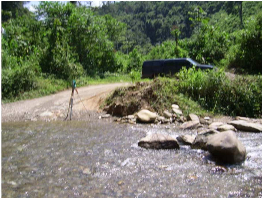
Foto 4. Km. 14+360 Vista hacia la Comunidad de Arroyo Macho
