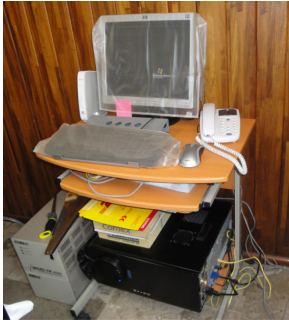
Figura 11. Lugar donde se encontraba el servidor
