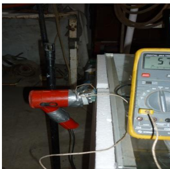
Figura 33. Generador de calor instalado en el ducto de distribución de aire para el proceso de desorción
