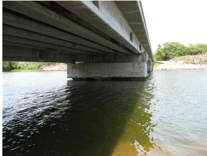
Figura II-12 Puente de la carretera federal No. 200
