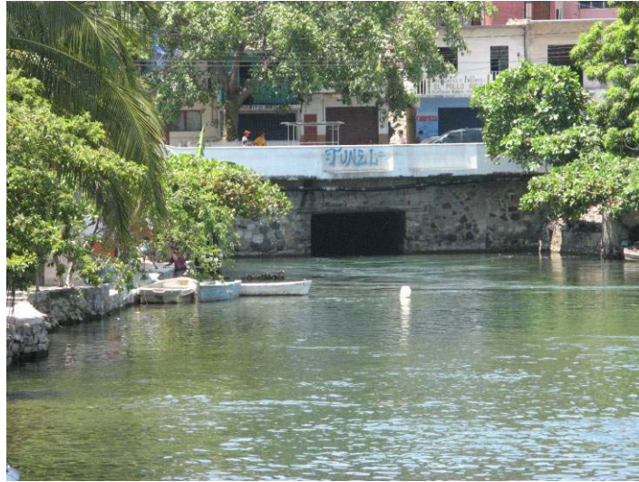
Figura II-10 Túnel del Porfiriato visto desde el canal
