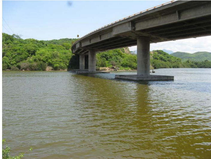
Figura II-14 Puente Tepalcates II en la garganta el Malecón
