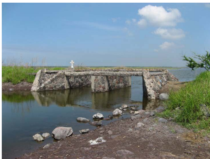
Figura II-17 Alcantarilla en el dique de separación entre el vaso III y IV
