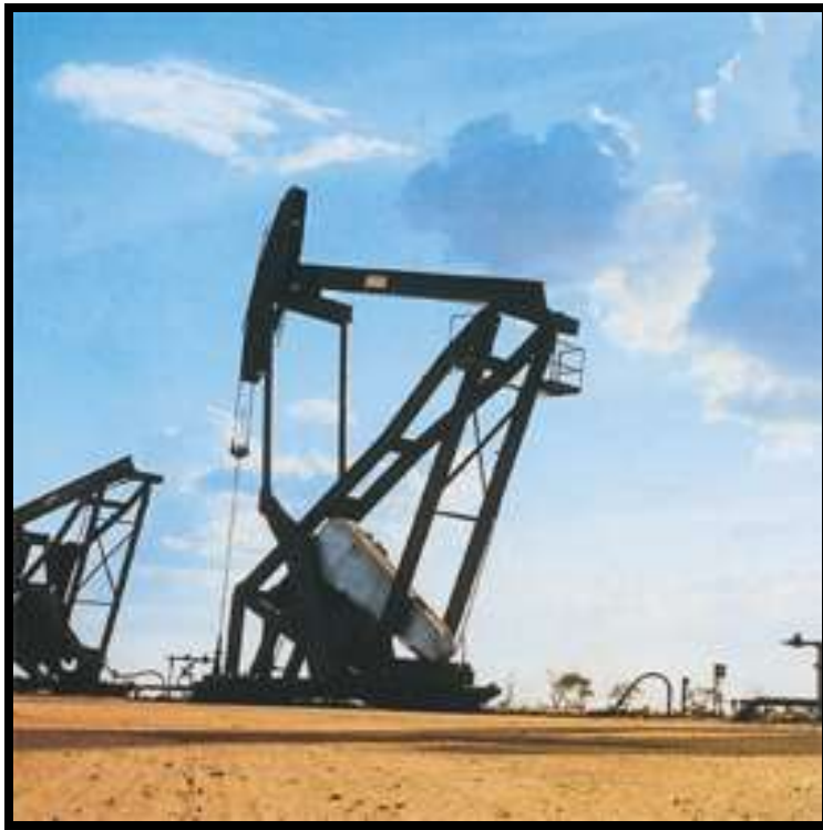
Figura 5.11- Pozo en el campo Yucal con bombeo mecánico.
