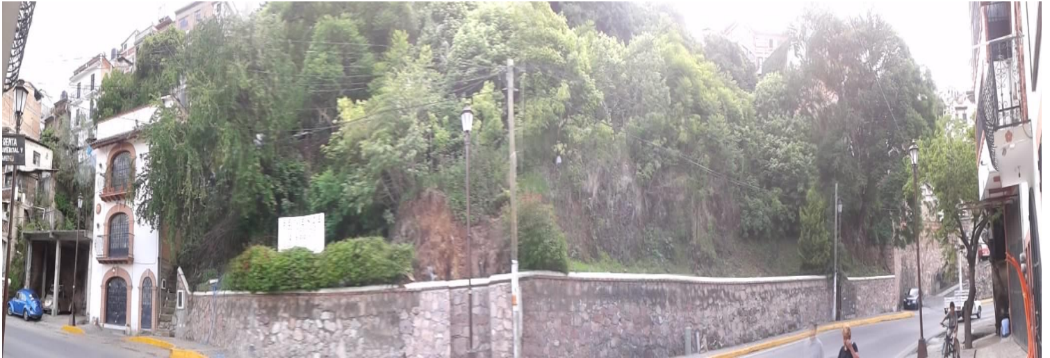
Fotografía V. 1 Estado Físico del terreno de la terminal norte.
