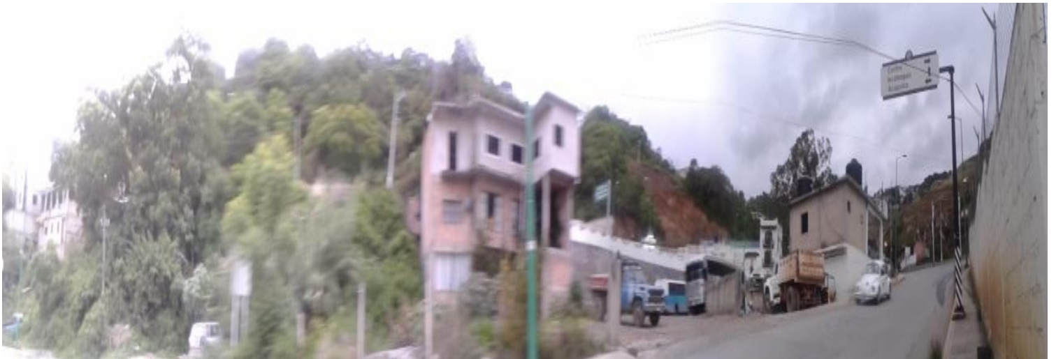
Fotografía V. 2 Estado Físico del terreno de la terminal sur.
