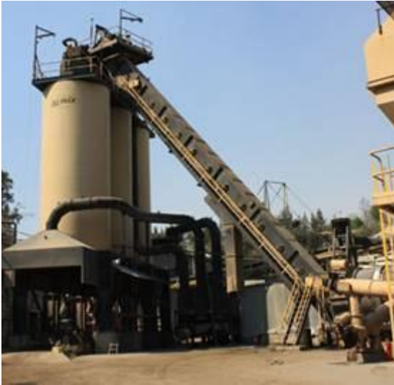
Foto 3.8.b.6 Planta de asfalto para elaboración de mezclas asfálticas en caliente.
