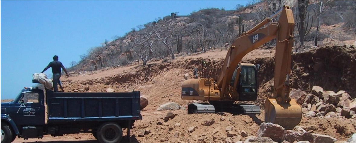
Foto 5.2 Corte y carga directa material tipo II.
