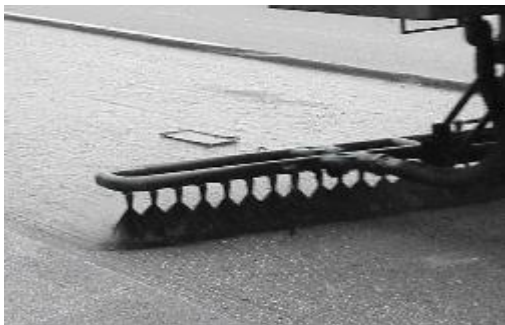
Foto 3.8.b.4 Riego de liga con emulsión asfáltica
