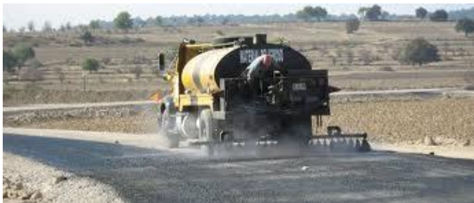
Foto 3.8.b.5 Riego de impregnación.
