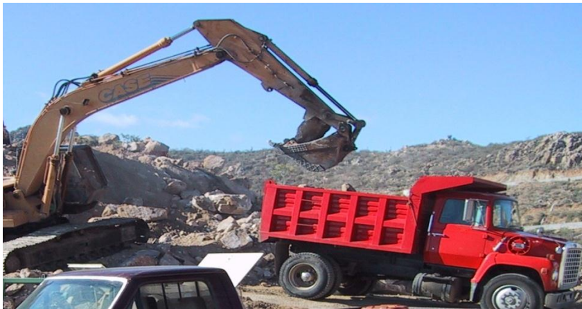
Foto 5.8 Carga y acarreo de piedra para muro.
