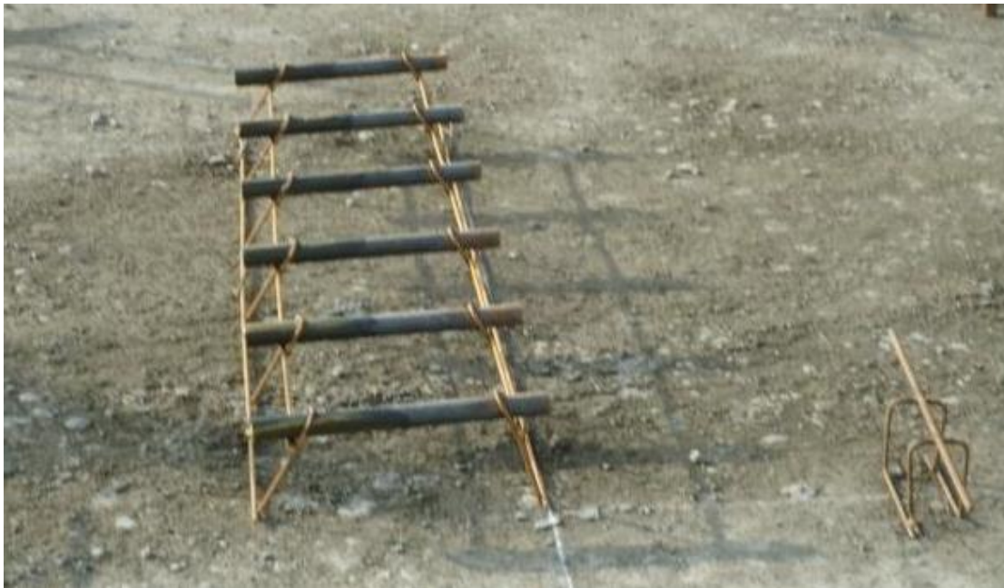
Foto 3.8.b.3 Armado de sistema de transferencia de cargas con pasa juntas.
