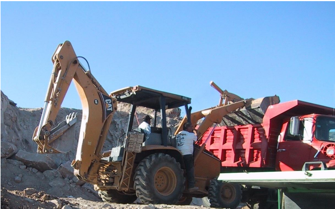
Foto 5.5 Carga de material tipo II.
