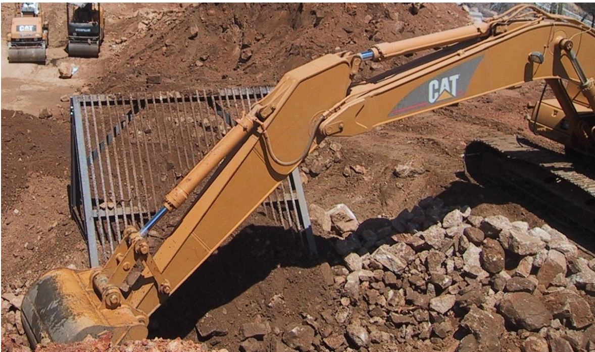
Foto 5.3 Cribado de material para piedra y material de relleno compactado.
