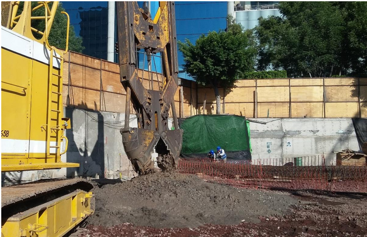
Foto 13. Retiro de material de excavación de zanja.
