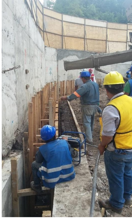
Foto 11. Colado de brocal.
