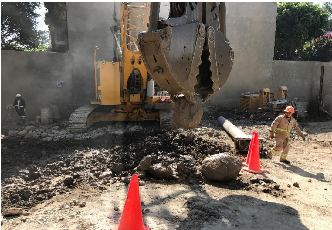
Foto 14. Boleos producto de excavación de aproximadamente 90 cm de diámetro.
