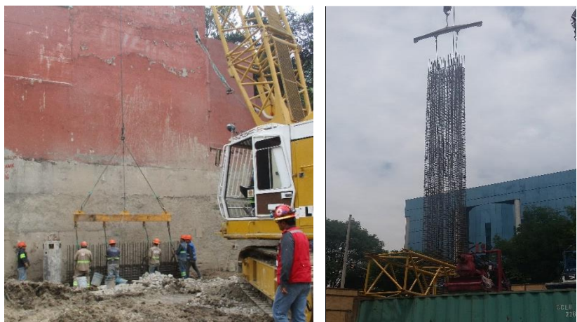
Figura 1. Elementos para izado de armado.
