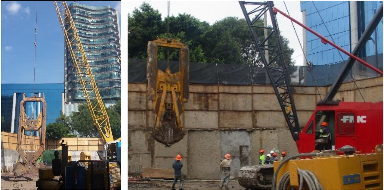
Foto 3. Equipo para la excavación.
