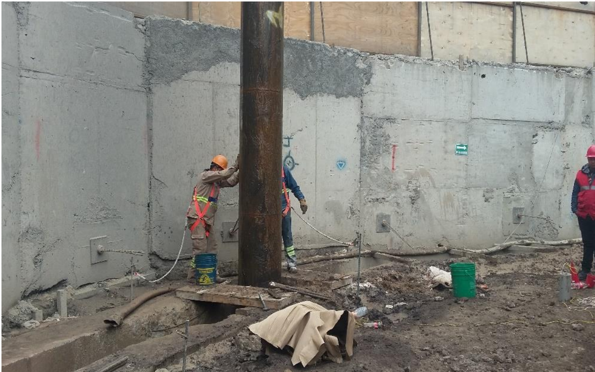
Foto 16. Colocación de junta en zanja.
