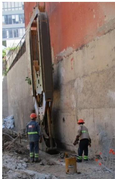
Foto 4. Excavación de zanja.
