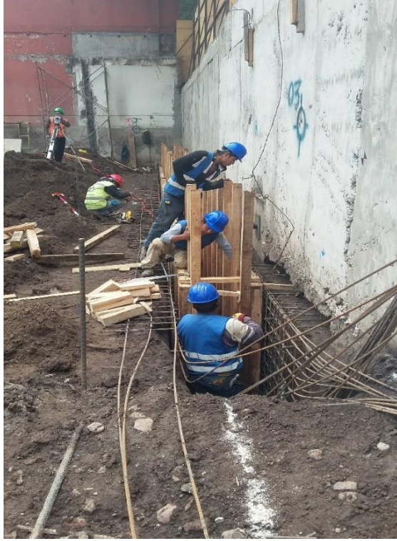
Foto 9. Cimbrado de brocal.
