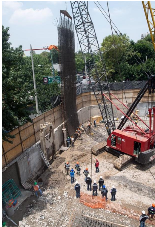
Foto 20. Colocación de armado en zanja.
