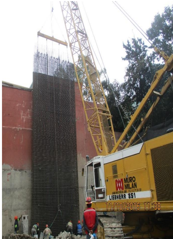
Foto 21. Descenso de armado en zanja.
