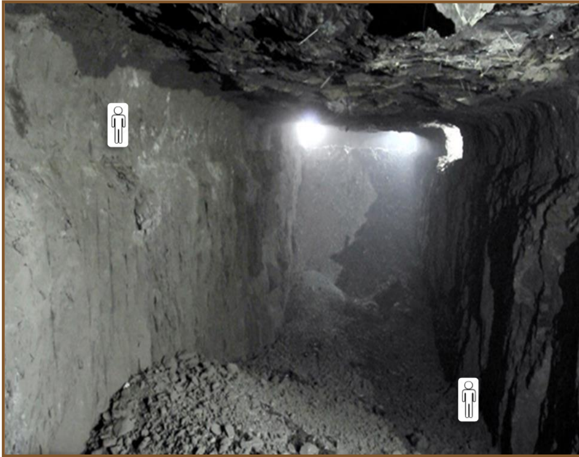
Figura N° 37. Resultado de la voladura en el acceso 4 del rebaje piloto mostrando el detalle del cuidado de los pilares cortina. Con la aplicación de la barrenación de post-corte se genera un buen marcaje de las medias cañas garantizando con ello su estabilidad; la granulometría se presenta en un rango P80 de 18 [in]. Las figuras representan, a escala, el tamaño de una persona
