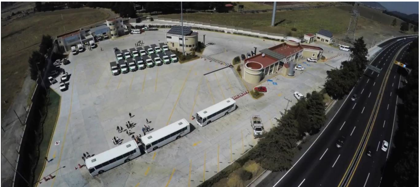
Ilustración 3. Parador Integral Parres Kilómetro 38+200 Autopista México-Cuernavaca.
