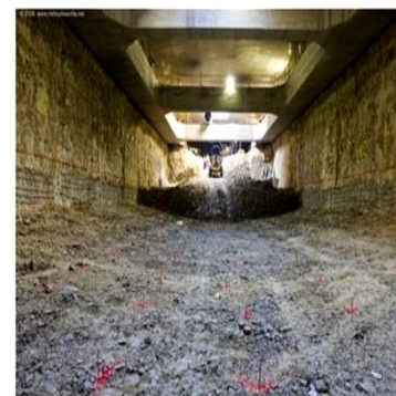
Figura 1. Ilustración de la técnica muro de pantalla
