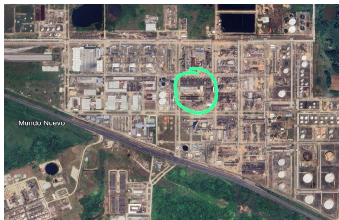
Figura 11. Imagen Satelital Complejo petroquímico Cangrejera, Ubicación de planta Generadora de Vapor dentro del Complejo.
