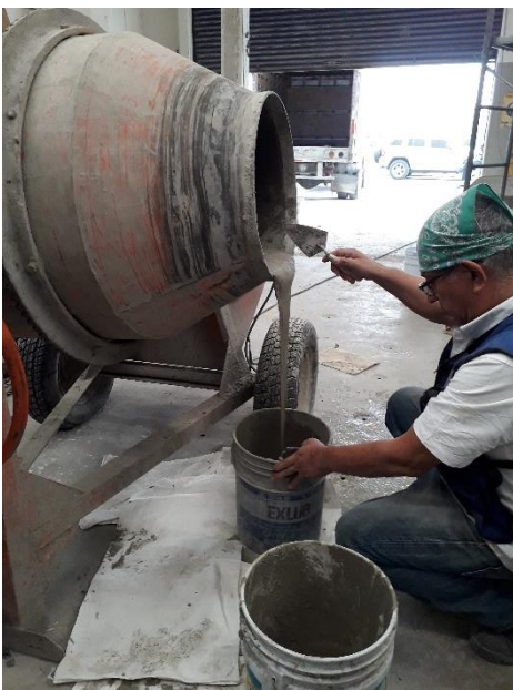
Figura 22. Mezcla de concreto con mezcladora tipo “Trompo” convencional
