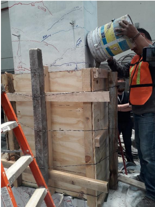
Figura 21. Vaciado del concreto Densocret-RF
