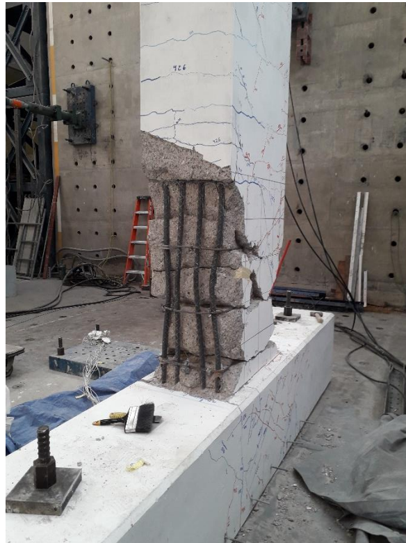
Figura 16. Limpieza y desprendimiento de material deteriorado
