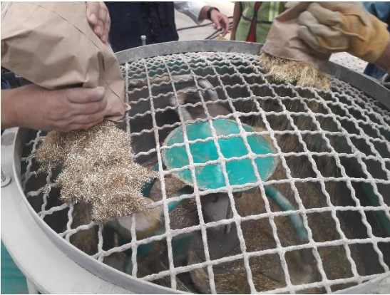
Figura 20. Mezcla de concreto con mezcladora satelital.
