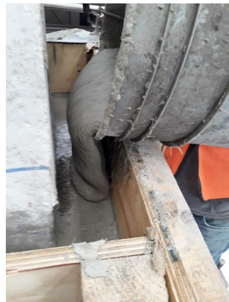
Figura 22. Mezcla de concreto con mezcladora tipo “Trompo” convencional
