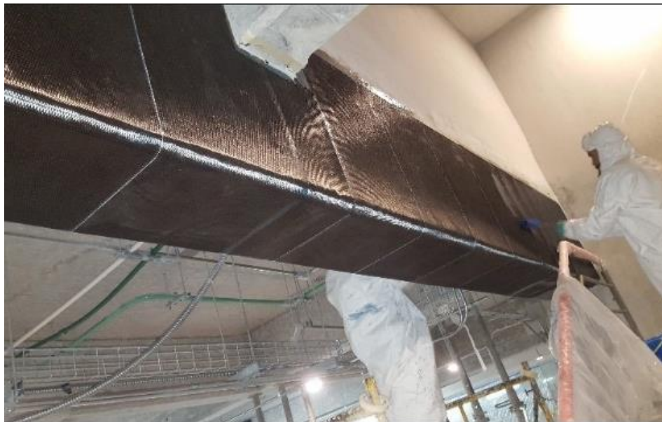
Figura 35. Trabe rehabilitada con fibra de carbono
