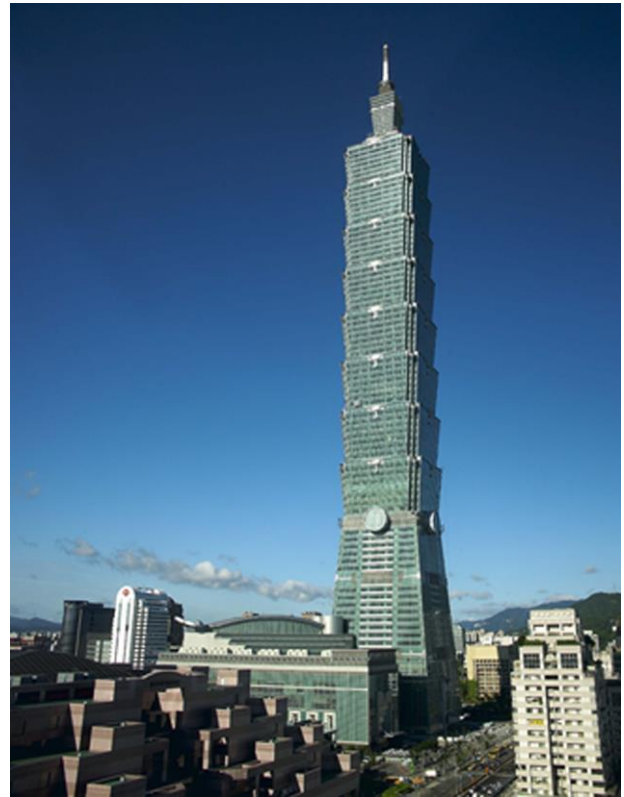
Figura 1.14.- Taipei 101. Taiwan, China Fuente: Marqos arquitectura
