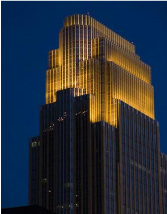
Figura 1.16.- Wells Fargo Center. Minneapolis, USA Fuente: Wikipedia
