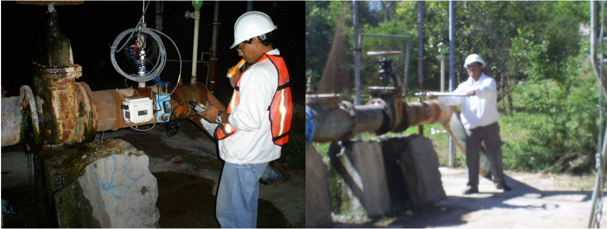
Figura 3.1. Instalación de válvula y medidor electromagnético a la descarga del pozo Santa Fe, de 10" de diámetro.
