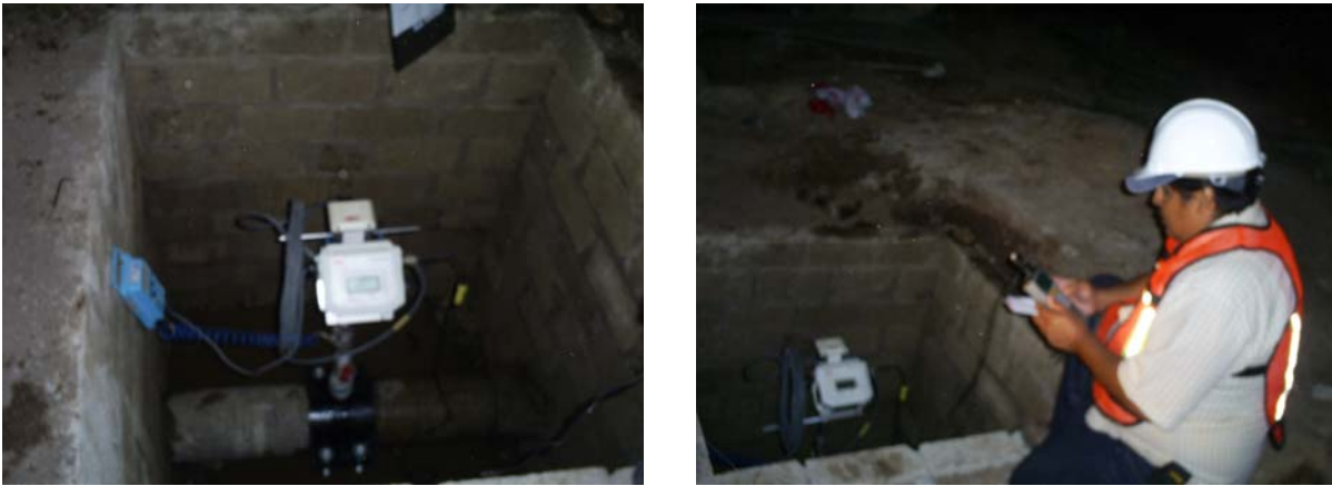
Figura 3.3. Instalación de Medidor electromagnético de inserción y un registrador tipo Log-Log, en tubería de 8" a la salida del tanque San Juan.
