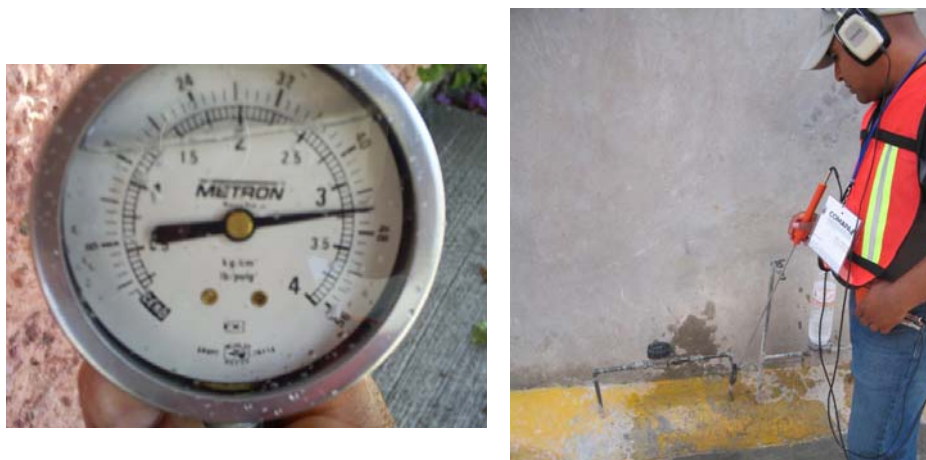
Figura 3.19. Detección de fugas no visibles con equipos electroacústico de detección directa, en tomas y su toma de presión
