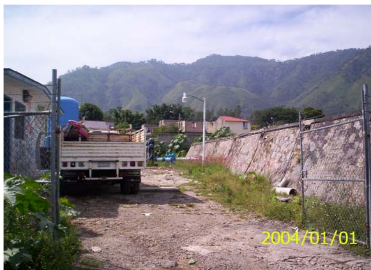
Figura 2.8. Tanque San Juan
