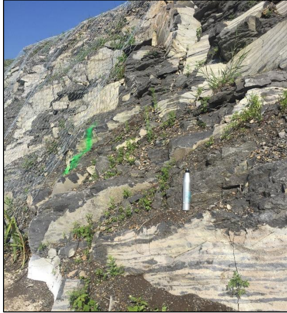
Figura 4.22 Ensayo de campo con martillo de Schmidt
