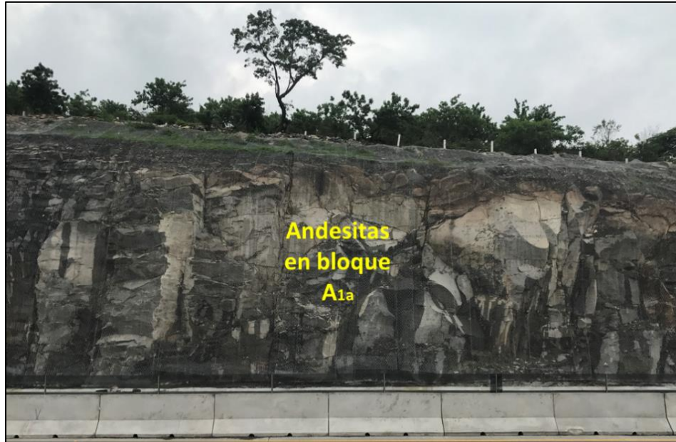
Figura 4.12 Andesita en bloques ( A_{1a} ), con amplio espaciamiento de sus fracturas, que delimitan bloques grandes.
