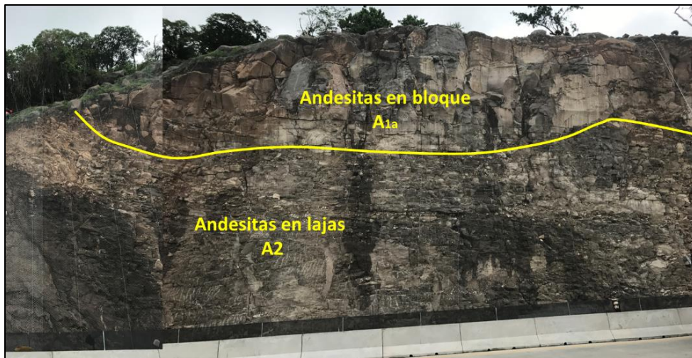
Figura 4.11 Diferenciación de las andesitas en función de su grado de fracturamiento.
