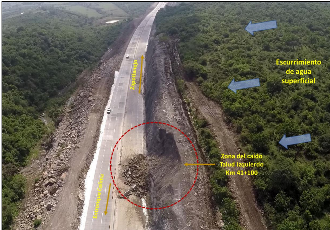
Figura 1.3. Vista panorámica del talud en la entrada, viendo hacia el Este.
