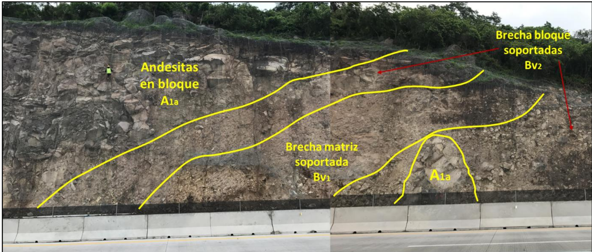
Figura 4.8 Brecha Volcánica formada por fragmentos de roca andesítica en matriz arenosa, con diversos grados de cementación y alteración
