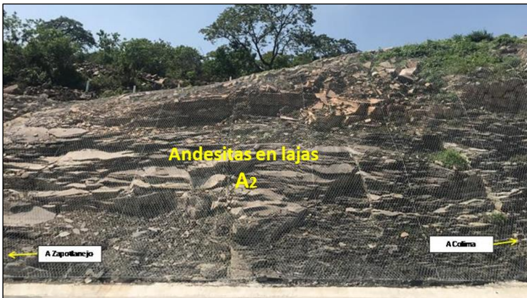
Figura 4.13 Andesita en lajas ( A_2 ), con espaciamiento cerrado de sus fracturas, que delimitan bloques pequeños.
