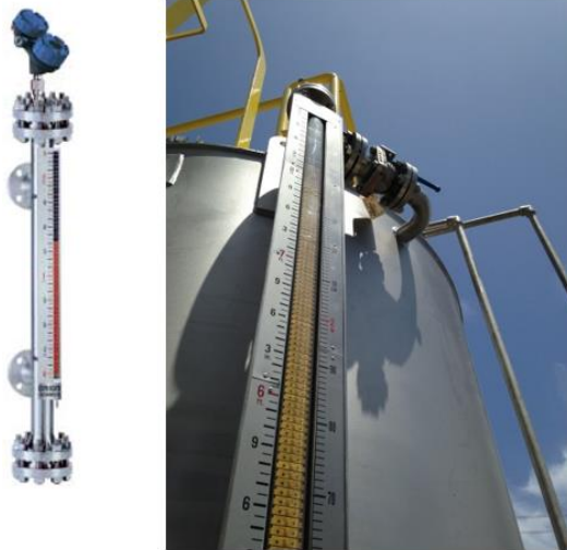
Figura 4.4 Indicador de nivel en tanques de almacenamiento de químicos.
